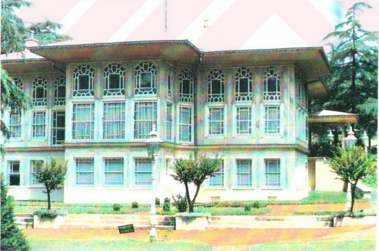
RESİM 28- Aynalıkavak Kasrının Güney Yönüne Bakan iki Katlı Arka Cephesi
