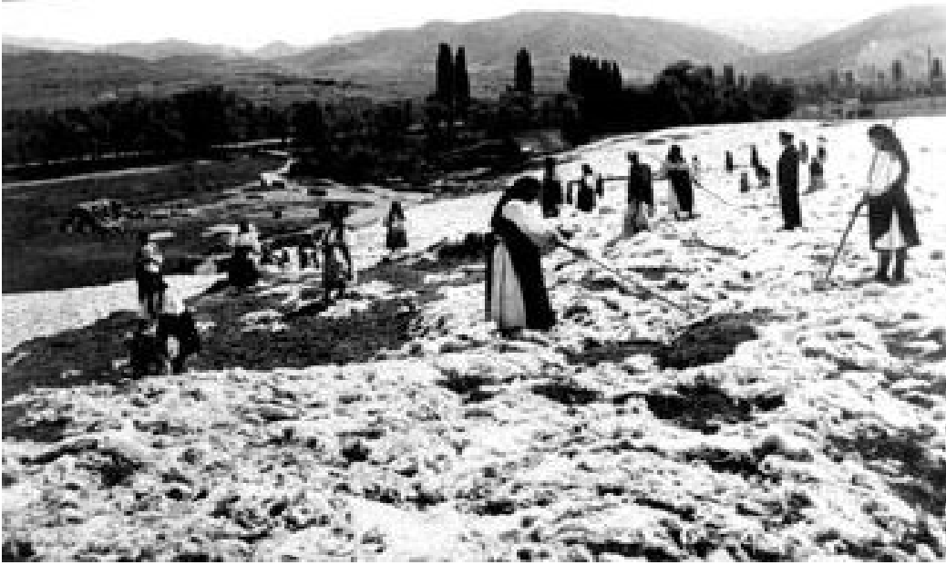
Fotoğraf 2. Dokumacılıkta Birinci Aşama Eğirme İşlemi Öncesi Yünün Havalandırılması
