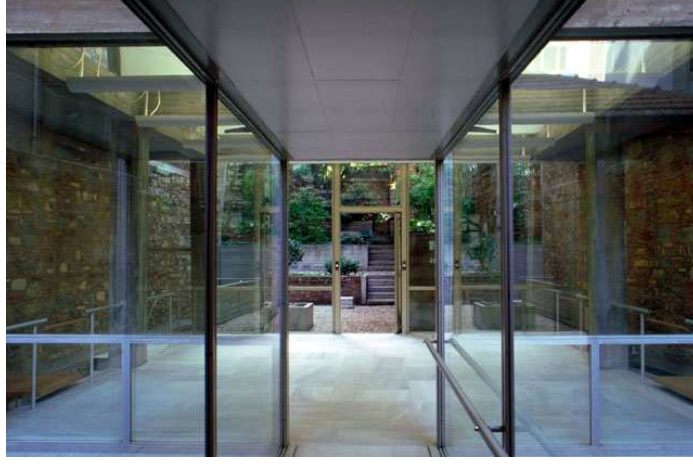
Şekil 3.21: Ayşe ve Ercümen Kalkın Vakfı, Ercümen Kalkın Müzesi Ek Bina İçerden Görünüş
