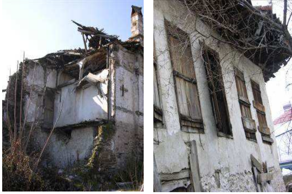
Şekil 3.83: Osman Hamdi Bey Müzesi Restorasyon Çalışmalarından Önce Cepheden Görünüş
