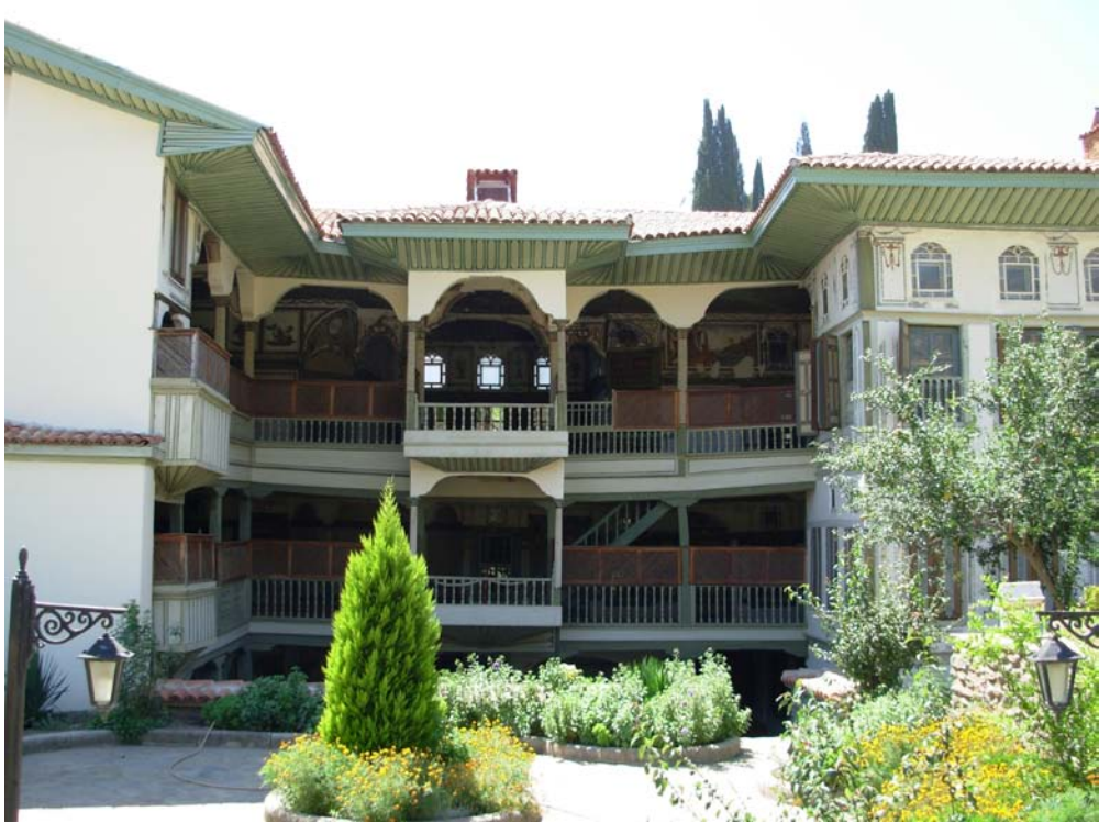
Şekil 28. Birgi Çakırağa Konağı Ön Cephe Görünüşü
