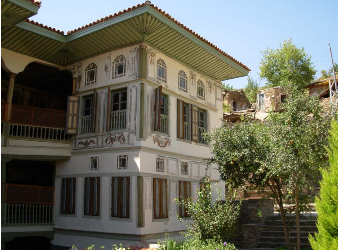
Şekil 29. Birgi Çakırağa Konağı Sağ Ön Cephesi
