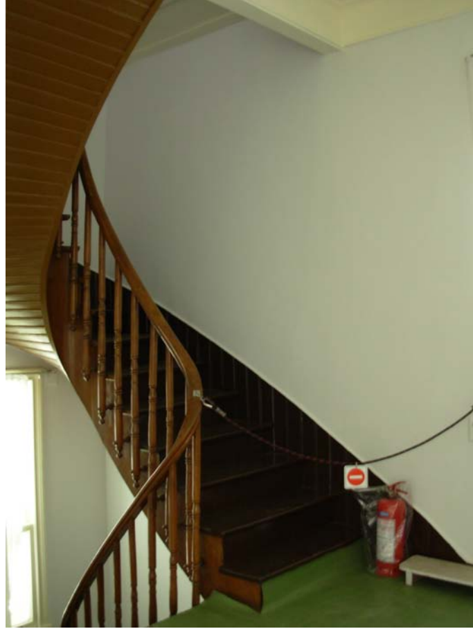
Şekil 52. Çatıya Çıkan Merdiven
