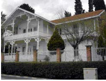
Bursa Belediyesi Hünkâr Köşkü
