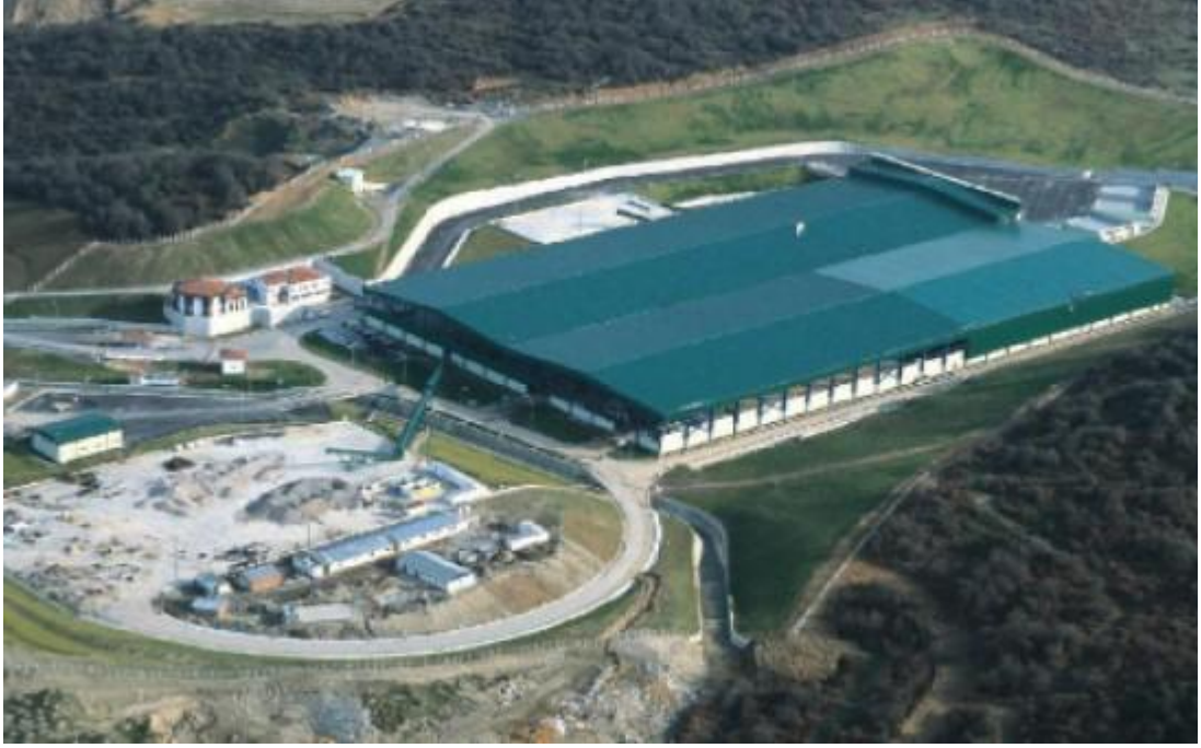
Şekil 4.2 İstanbul Kompost ve Geri Kazanım Tesisi'nin görünümü
