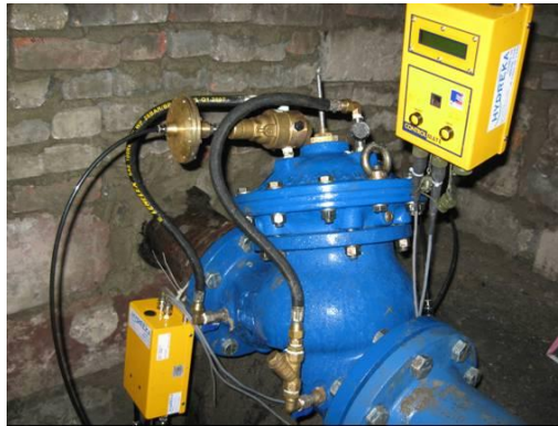
Şekil 5.51 Üst bölgede (kuzey-batı) monte edilen aktif basınç kontrol cihazı
