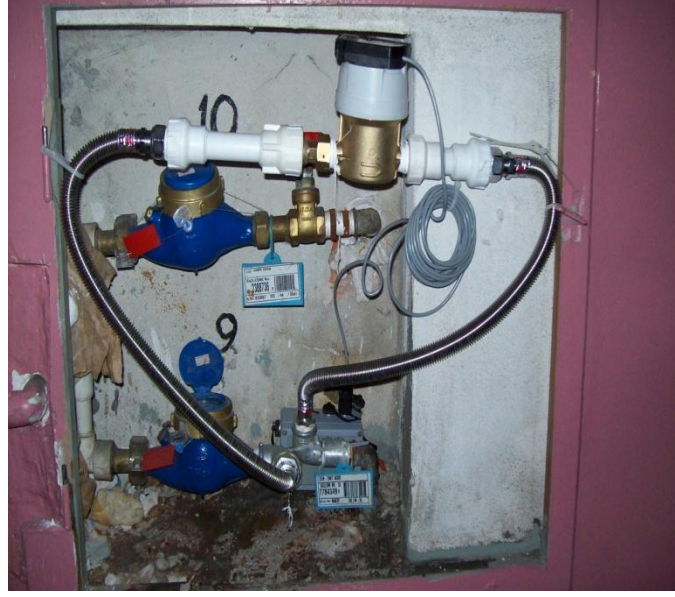
Şekil 5.17 Normal abone sayacına seri bağlantı yapılan pilot sayaç
