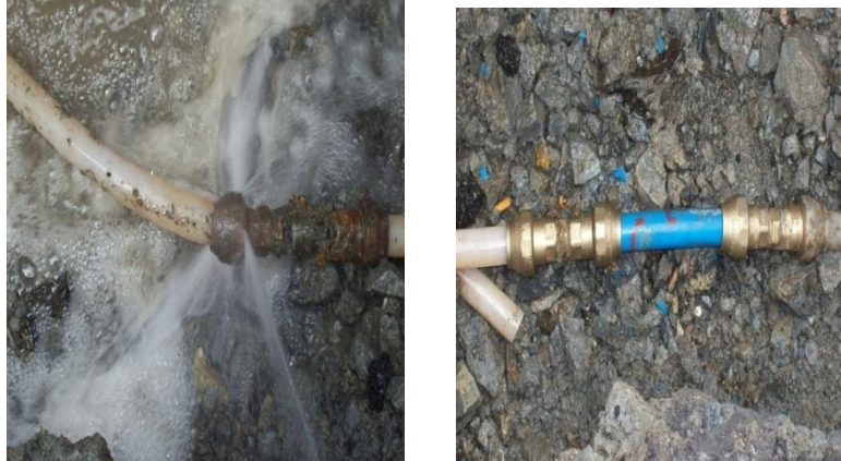
Şekil 5.31 Üçüncü su kaçağının tespiti ve onarımı
