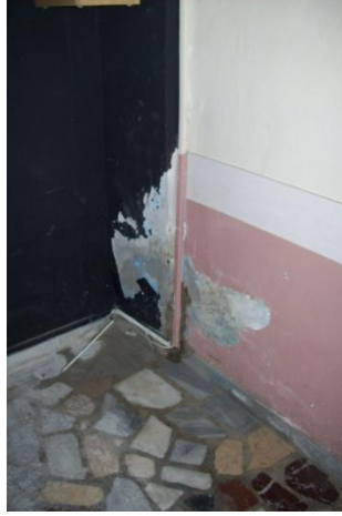
Şekil 5.34 Abonenin bodrum katındaki su kaçağı
