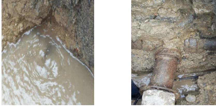
Şekil 5.30 İkinci su kaçağının tespiti ve onarımı
