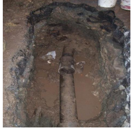
Şekil 5.29 Birinci su kaçağı tespiti ve onarımı
