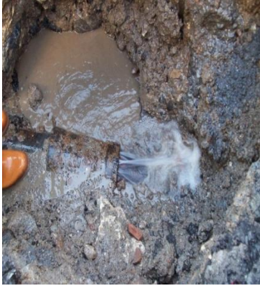
Şekil 5.29 Birinci su kaçağı tespiti ve onarımı
