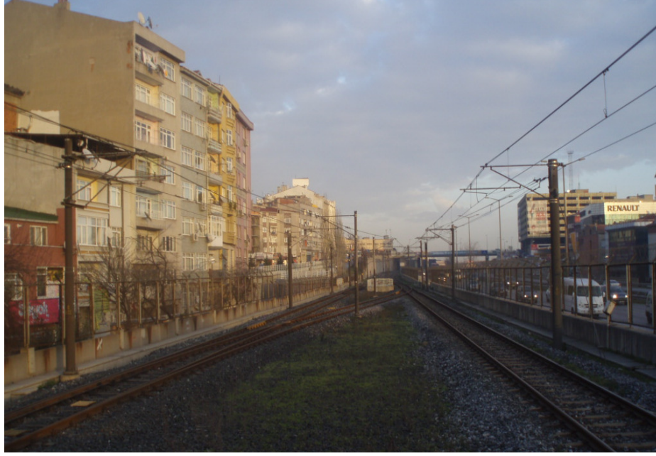
Şekil 7.14 Sağmalcılar mevki metro yolunun görünümü
