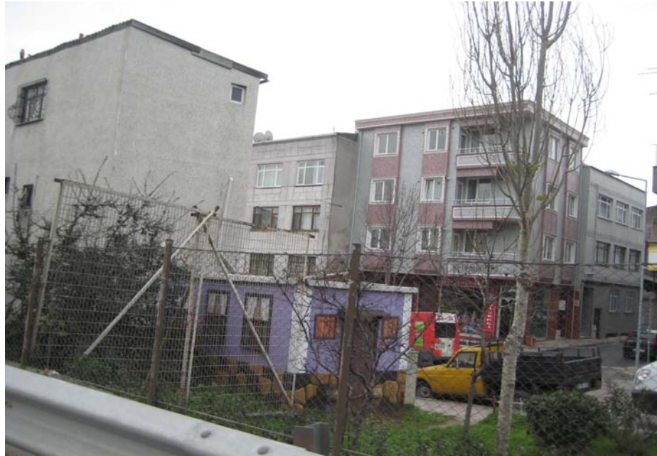
Şekil 7.12 Aksaray yönünde Birinci Ölçüm Noktası görünümü
