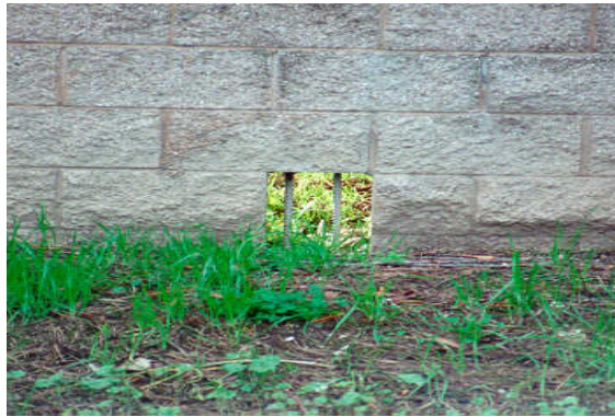
Şekil 5.9 Gürültü perdesi drenaj yapısı görünümü (FHWA, 2007)
