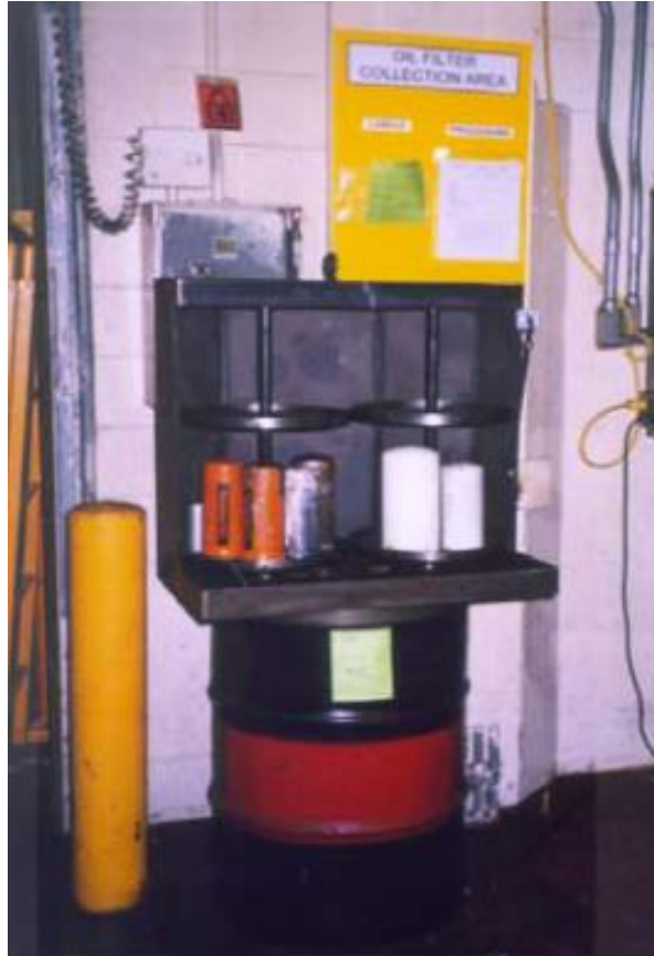
Şekil 4.14 Atık filtre süzme ve sıkıştırma mekanizması
