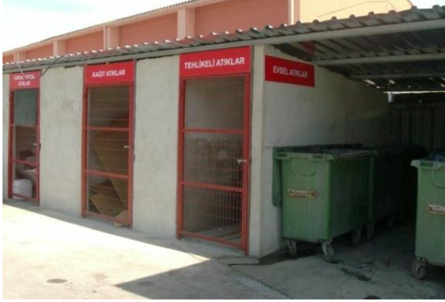
Şekil 4.6. Yeni inşa edilmekte olan bir geçici depolama alanı
