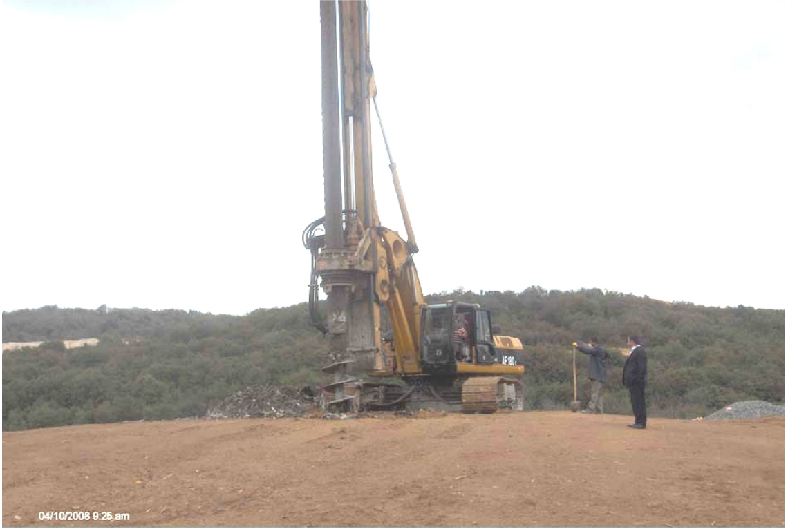
Havalandırma borusu ve gaz bacaları için sondaj çalışması
