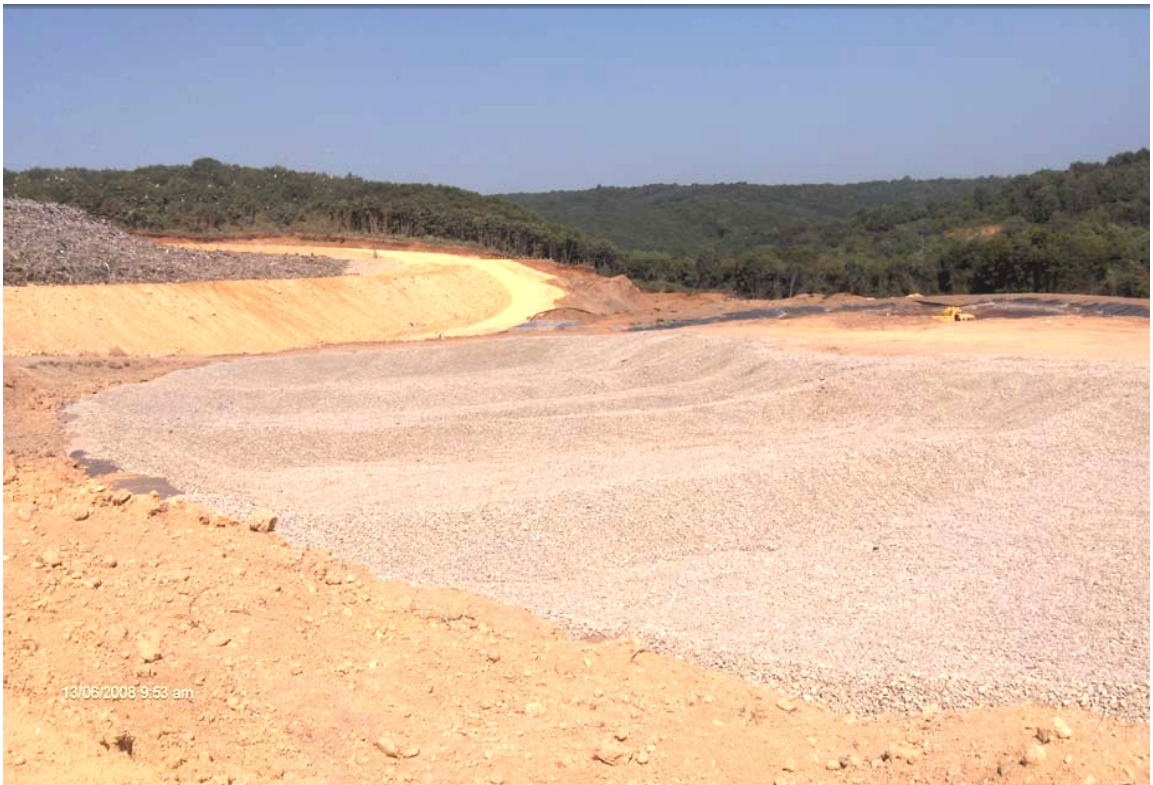
Test hücrelerinin tabanına çakıl tabakasının serilmesi
