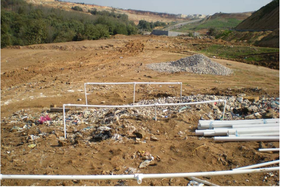
Havalandırma borularının yerleştirilmesi
