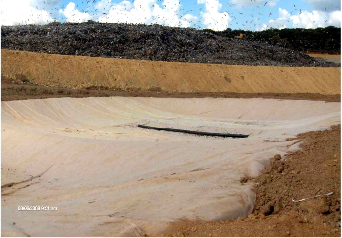
Test hücrelerinin tabanına geotekstil serilmesi
