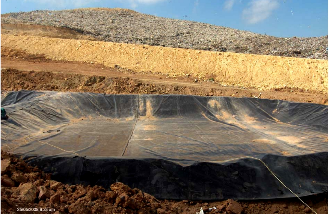
Test hücrelerinin tabanına membran serilmesi
