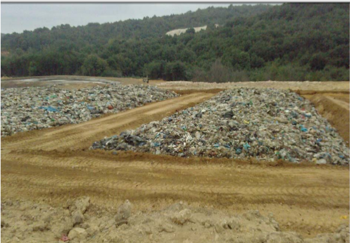
Test hücrelerinin katı atıklarla doldurulması
