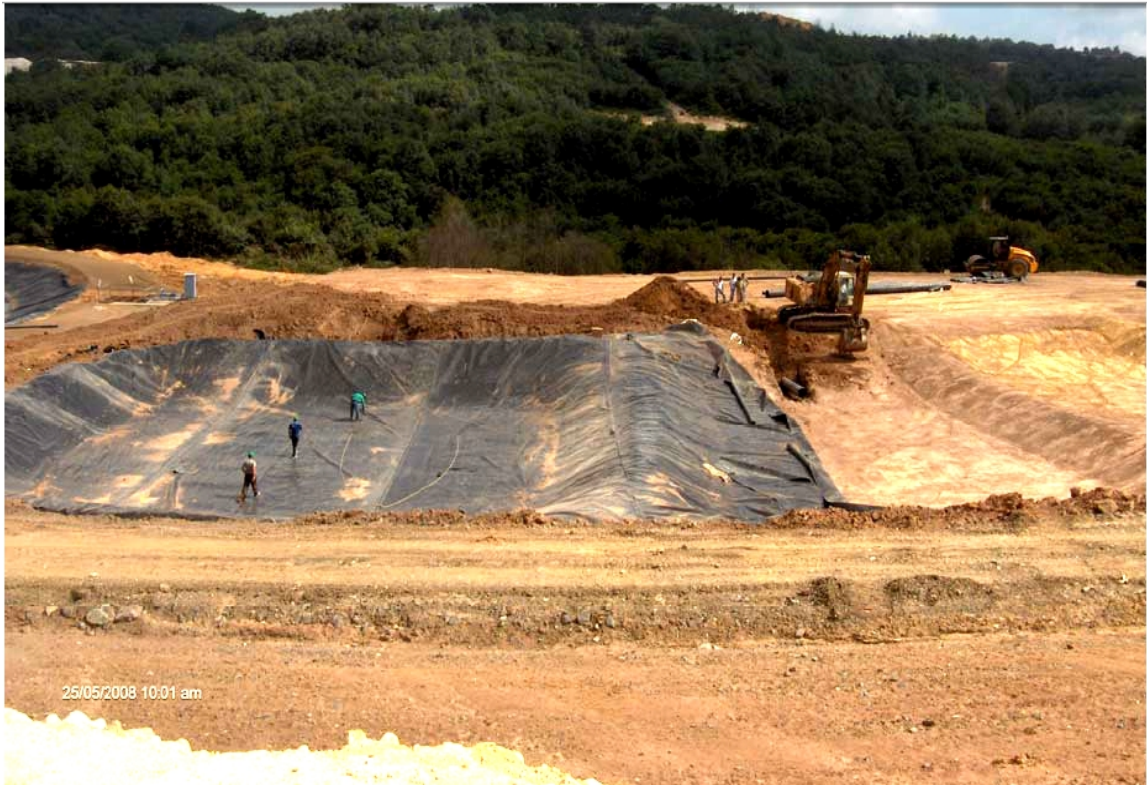
Test hücrelerinin membran serilmesi ve drenaj sistemi
