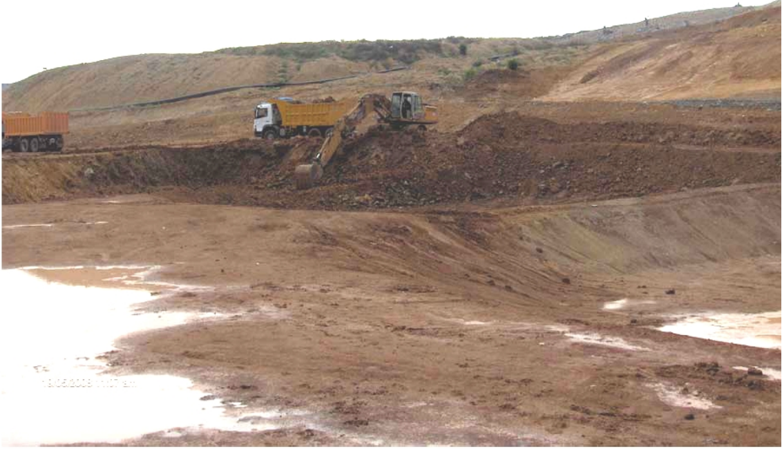
Katı atık test hücreleri için yapılan hafriyat çalışmaları
