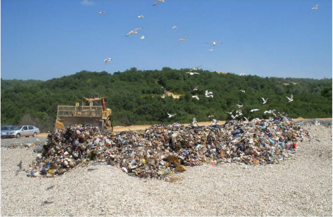
Test hücrelerinin katı atıklarla doldurulması
