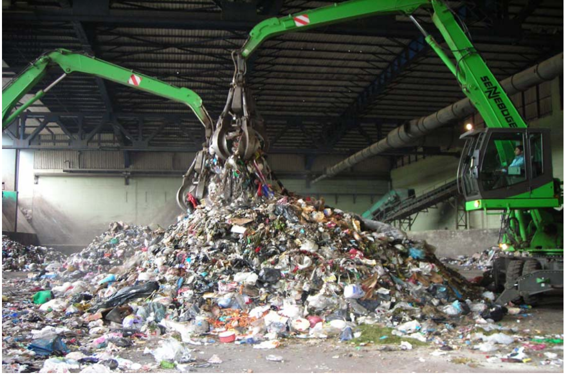
Resim Ek-1.1 RO reaktörüne beslenen atıkların alındığı İ.B.B Geri Kazanım ve Kompost Tesisi atık kabul bölümü
