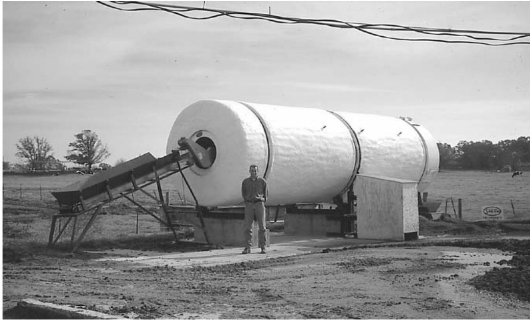
Resim 3.7 Küçük ölçekli döner tanbur kompost reaktörü (Stofella ve Kahn, 2001)
