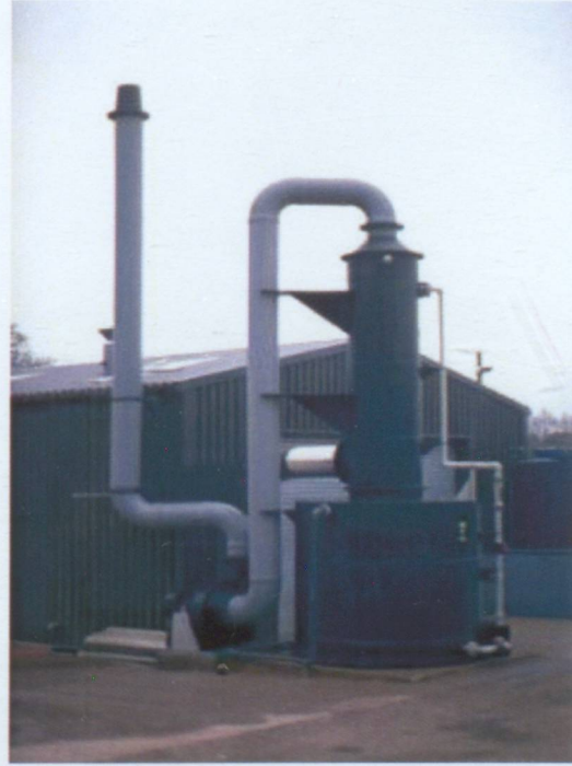
Şekil 4.17 Akışkan yataklı ıslak arıtıcı (fluidised-bed scrubber).
