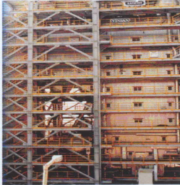
Şekil 4.5 Atık ısı kazanı (Boylar)
