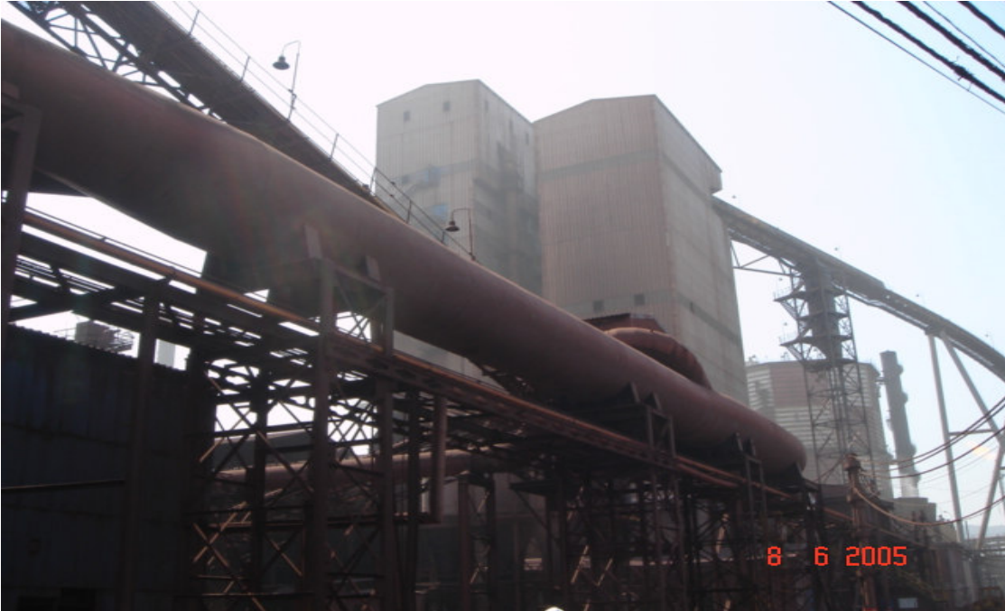
Şekil 4.4 Siklon sistemi giriş hattı
