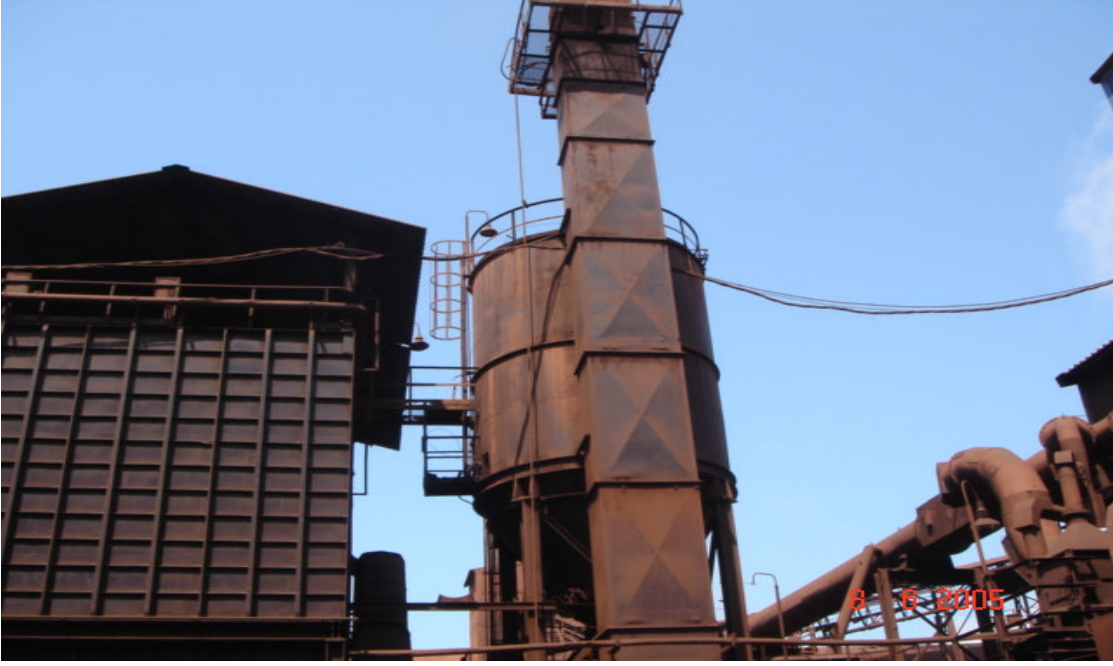
Şekil 4.3 Siklon sistemine bağlı çıkış bacası
