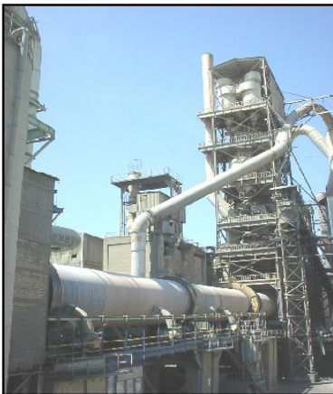
Şekil 6.6 Tesisteki sırasıyla üç döner fırın Akçansa A.Ş.
