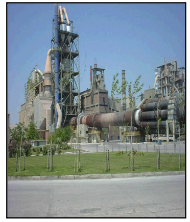
Şekil 6.6 Tesisteki sırasıyla üç döner fırın Akçansa A.Ş.
