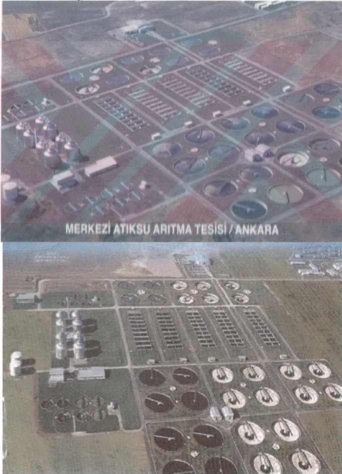
Şekil 5.3 ASKİ Arıtma Tesisinin Görünümü
