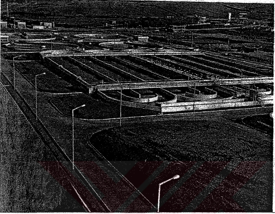
Şekil 4.9 Paşaköy ileri biyolojik arıtma tesisinin görünüşü
