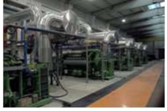
Şekil 6.4 Depo gazından enerji üretim tesisi
