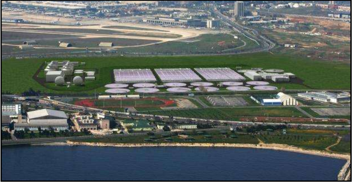
Şekil 6.6 Ataköy ileri biyolojik arıtma tesisi genel görünüş
