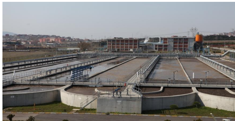
Şekil 2.2 Bir havalandırma havuzundan görünüm [17]
