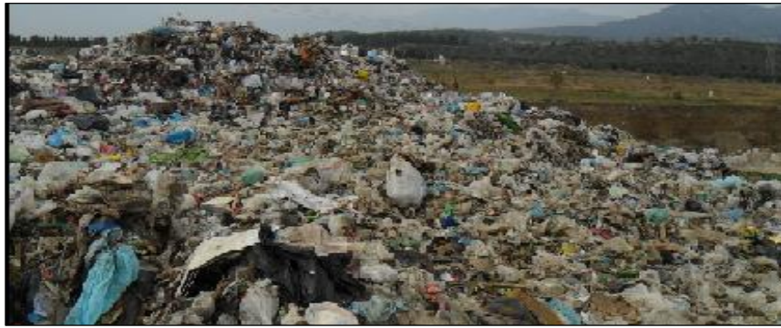
Şekil 4. 14 Gömeç ilçesinin mevcut düzensiz depolama alanının genel görünümü
