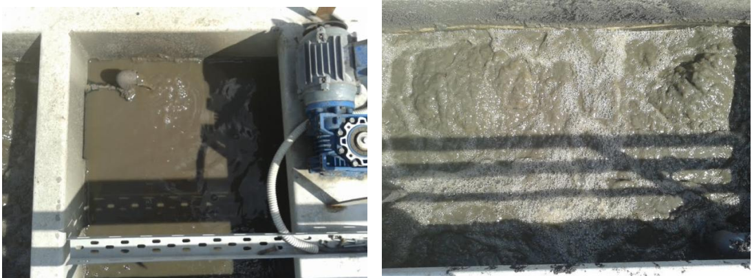
Şekil 6.2 Çalışmada kullanılan pilot tesisin anoksik ve aerobik tanklarının görünümü.
