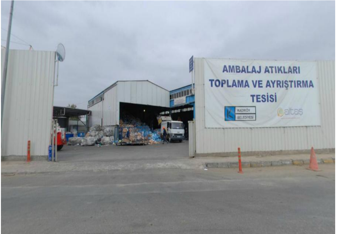
Şekil 5.7 Toplama ayırma tesisinin girişi ve tesise giren atıkların kabul alanı
