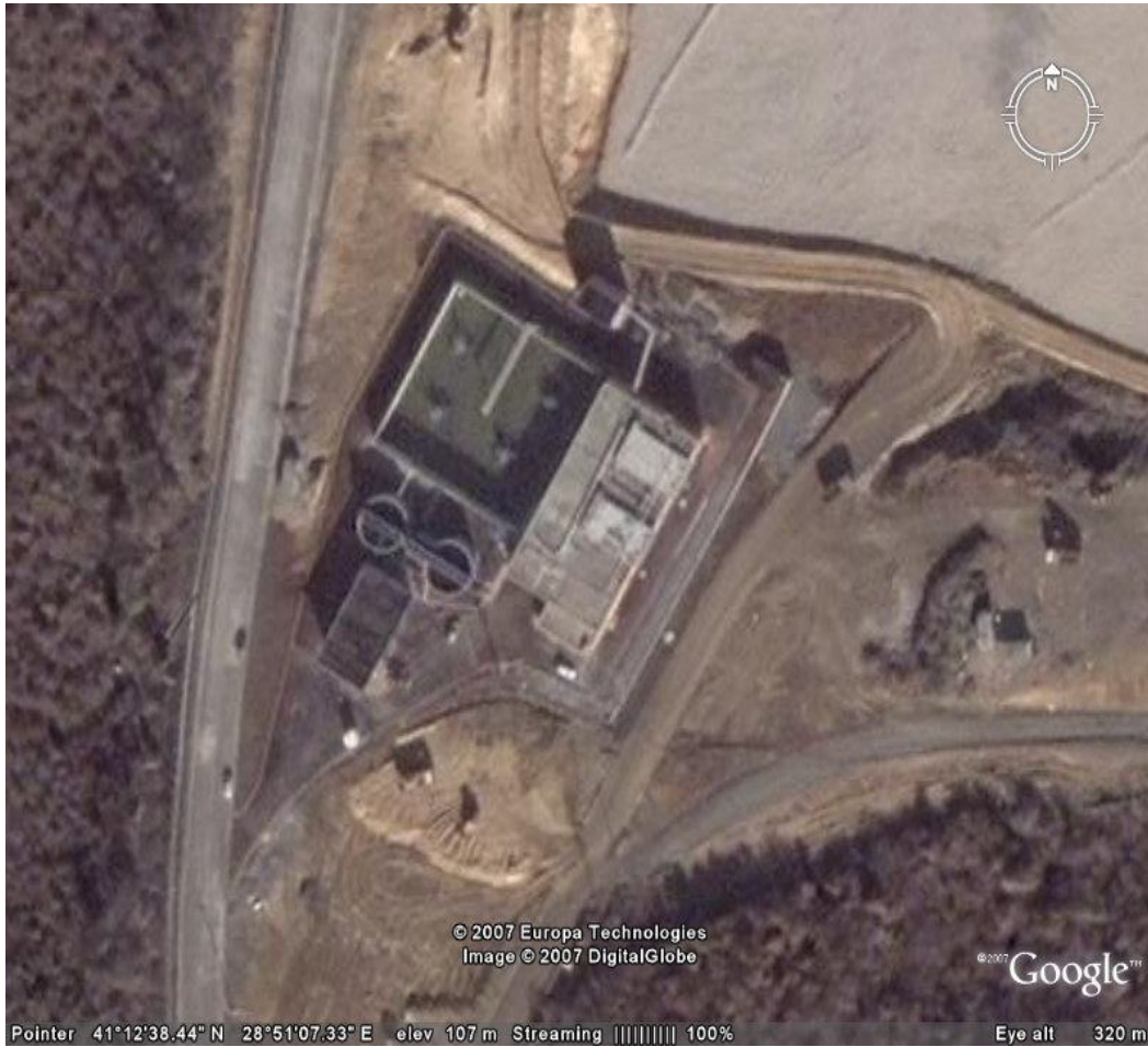
Şekil 4.2 Odayeri sızıntı suyu arıtma tesisi genel görüntüsü [15]
