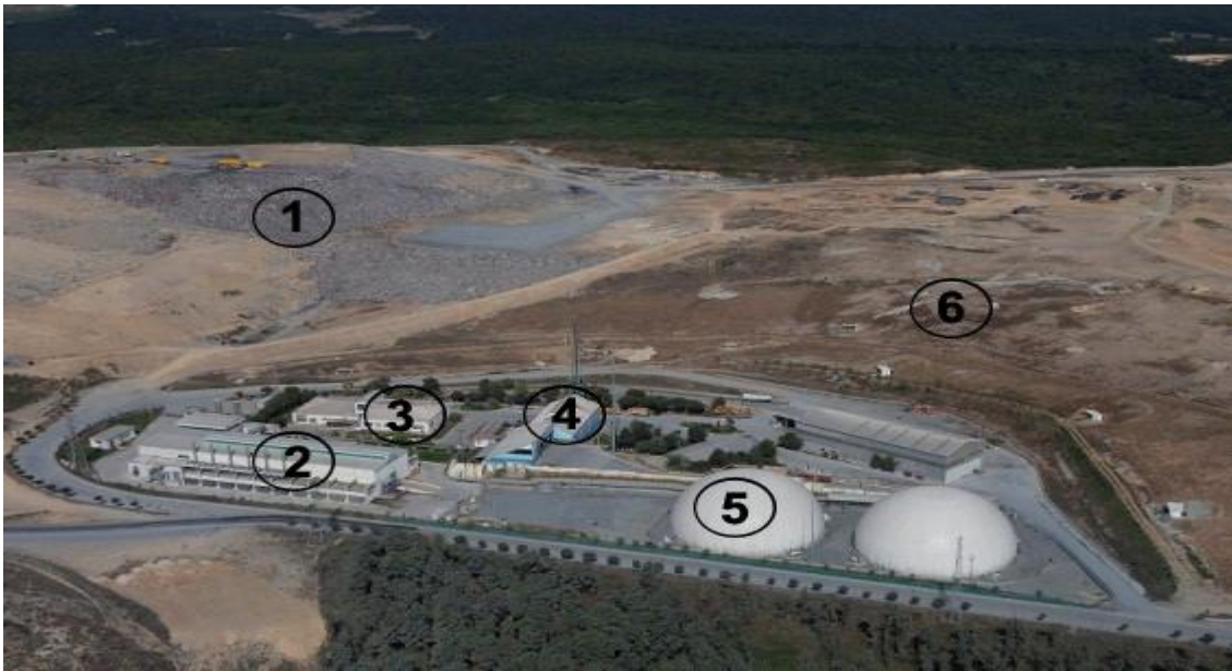
Şekil 4.1 Depo sahası genel görünümü ve enerji tesisi ( 1 : Yeni depo sahası, 2:Elektrik üretim tesisi, 3 : İdari bina, 4 : Yakma tesisi, 5 : Gaz balonları, 6 : Eski depo sahası)
