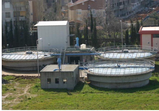
Şekil 5.5 Çamur yoğunlaştırma havuzları
