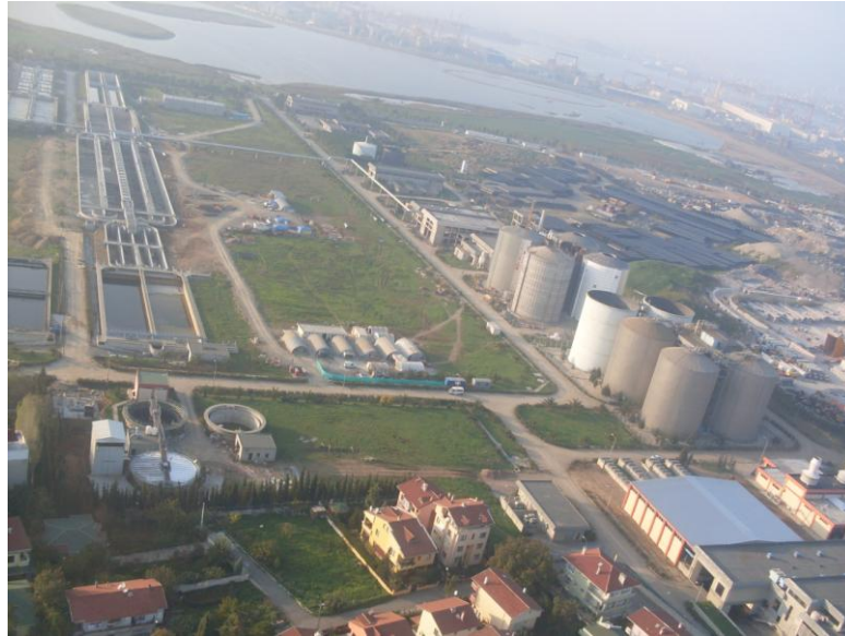
Şekil 5.1 İSKİ Tuzla biyolojik ve ileri biyolojik atıksu arıtma tesisi
