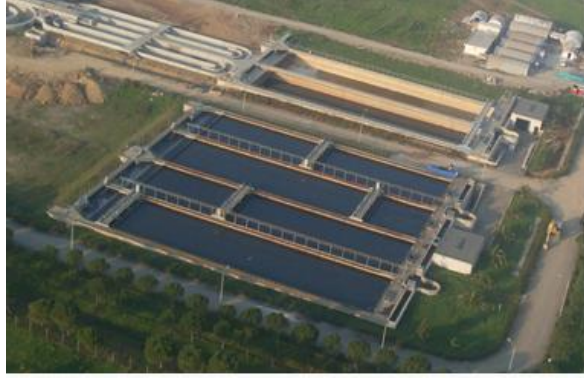
Şekil 5.3 Ön çöktürme havuzları
