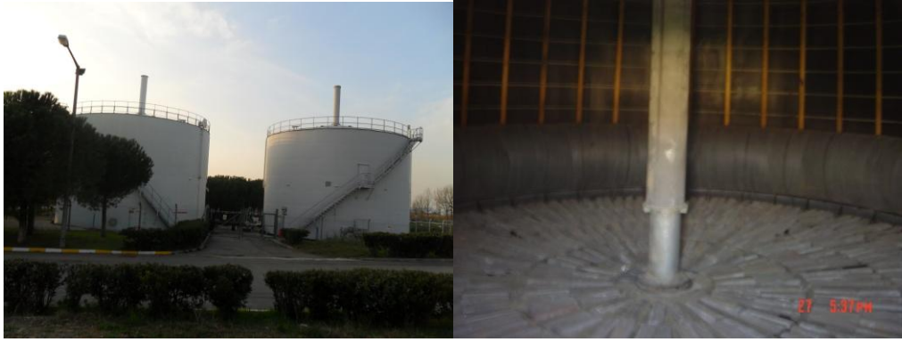
Şekil 5.12 Biyogaz depolama tankları ve biyogaz tankları içerisindeki neopren balon
