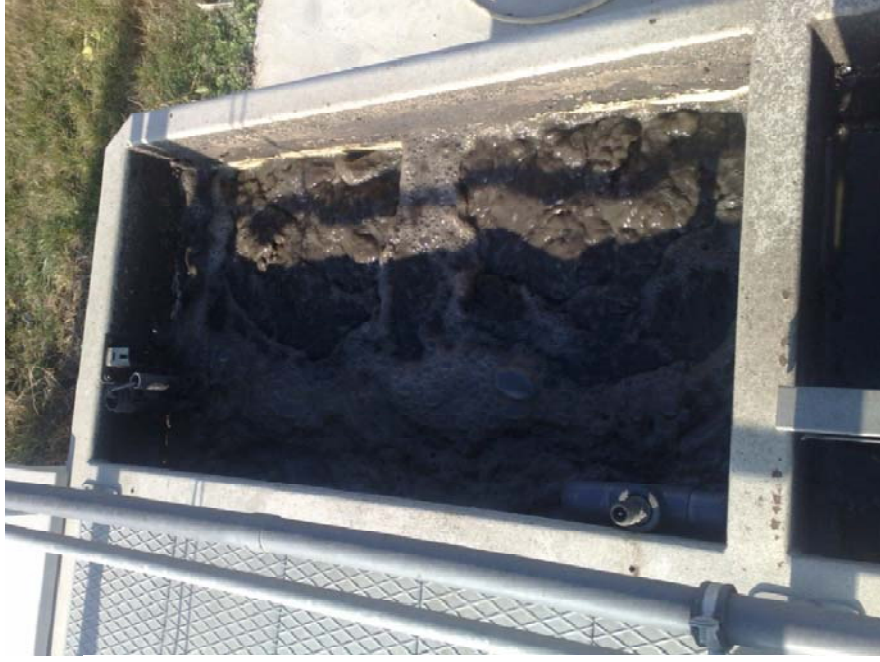
Şekil 5.5 Aerobik2 havuzunun üstten görünüşü
