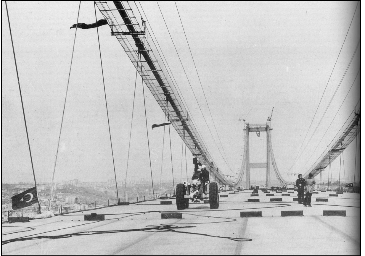
Şekil 3.54 Boğaz köprüsü yapım aşaması
