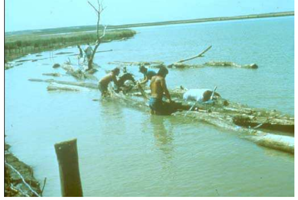
b-Sharpe Gölü'ne Ağaç kütüğü dalgakıranının yerleştirilmesi, Güney Dakota, 1989.
