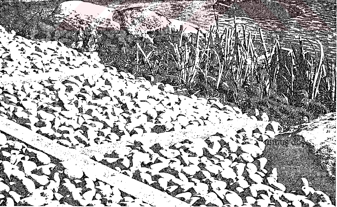
ŞEKİL8. Sıkıştırılmış kum ve serbest iri çakıl taşları ile oluşturulmuş döşemeler.
