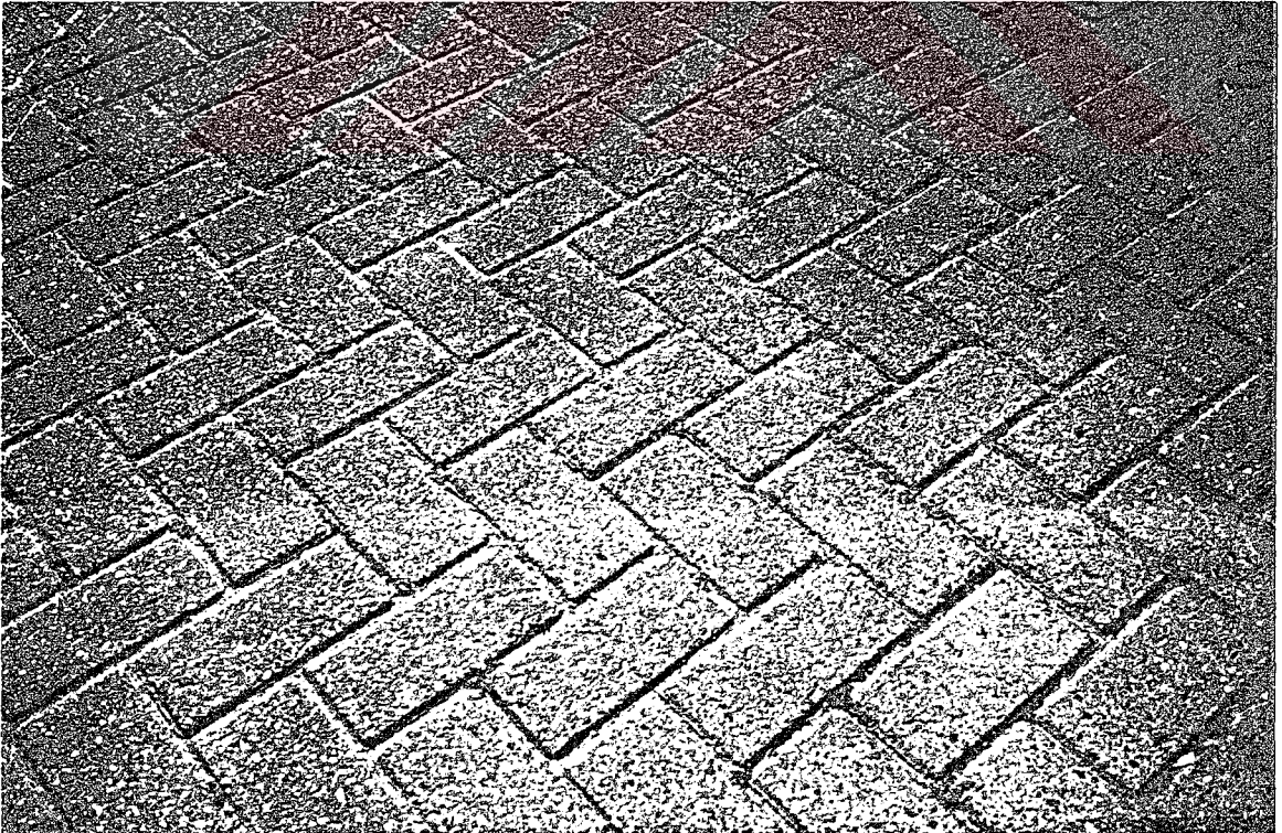
ŞEKİL 28. Her iki yöne 45 derecelik açıyla taban tuğlaları ile oluşturulmuş balıksırtı bir yaya yolu. ( HOLLANDA )
