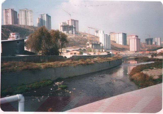
Fotoğraf 4.15: Taban alanından başlayıp sırtlara kadar çıkan konut gelişme bölgesinde inşaat esnasında büyük hafriyatlar yapılmıştır. Binalar tabanda geniş alan kapsamakta olup yüksek katlıdır. Bu nedenle batı bakılı (güneşli) yamaçta, konutların doluluk oranının %100'e ulaşmasıyla sıcaklık fazla (binaların yüzeyleri ve asfalt alanlar güneş enerjisini absorbe ederler) olacak ve hava sirkülasyonu büyük ölçüde azalacaktır.
