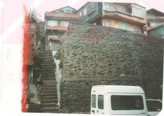
Fotoğraf 4.32.4.33.4.28 : Alibey Kemirburgaz yolu üzerinde vadi tabanından başlıyan konut adsında eğim oranının fazla olması nedeniyle konutlar arası ulaşım çok basamaklı merdivenlerle sağlanmaktadır. İnşaat esnasında yüksek istinat duvarları çıkmaktadır.
