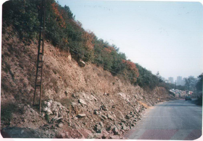
Fotoğraf 4.11: Kağıthane - Kemberburgaz yolu geçirilmesi esnasında hafriyat yapılarak relief bozulmuştur. Hafriyat esnasında bitki örtüsü yok edildiği için toprak ve taşlar yola doğru kaymaktadır.
