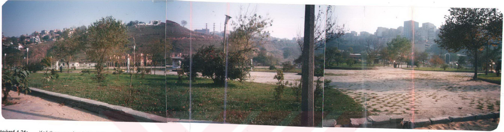
Fotoğraf 4.21: Kağıthane merkez bölgesinde vadinin yan kolunda park alanı düzenlenmesi yamaçlarda çok yoğun ve plansız yapılaşma olgusu görülmektedir. Park düzenlenmesinde doğal ortam oluşturma çabası gösterilmeden, çok geniş alanları kapsayan sert zemin malzeme ile yollar yapılmıştır.
