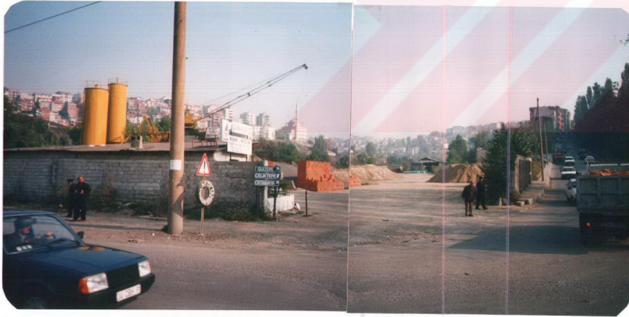
Fotoğraf 4.22: Kağıthane merkez bölgesinde inşaat malzemeleri satan bir işletme. Vadinin batı bakılı yan kolunda taban alanına yerleşmiş işletme çok geniş bir alan kaplamakla beraber zeminin tamamı asfalt yüzeyle kaplıdır. Yamaçlardaki yoğun konut alanlarının beton yüzeylerde dikkate alındığında bu güneşli bakının sıcak olacağı muhtemeldir. Aynı zamanda inşaat malzemeleri satılan bölgeden çevreye partiküler maddeler verilmektedir.
