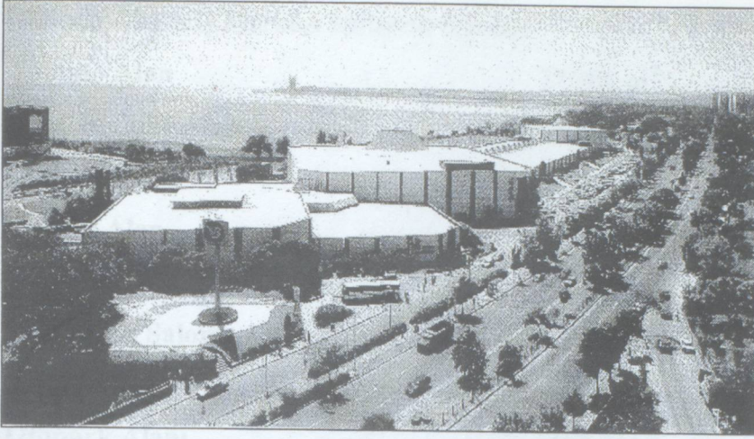
Foto 5.1 Galleria Alışveriş Merkezi uzaktan görünüş
