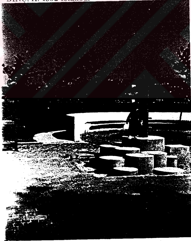
Resim 5: Cemil Topuzlu Parkında Tırmanma sırtığı. İnıp-çıkmaı oıağı çocukların hořuna gitmektedir. Fakat oturdugu yumuřak zemin, büyüklüğü yetersiz, sert zeminle aynı püzeyde olmadıgından tace- lip düřmektedir.
