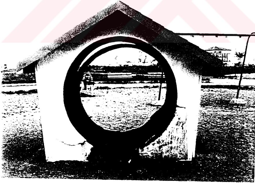
Resim 4. Zeytinburnu Dericiler önü park oyun alanı Kulübe içinde tambur. Bakımsızlıkta ve tamburun paslı olması çocuklar tarafından kul- lanımı sakıncalı hale getirmiştir. DİNÇ, H. 1993-İstanbul
