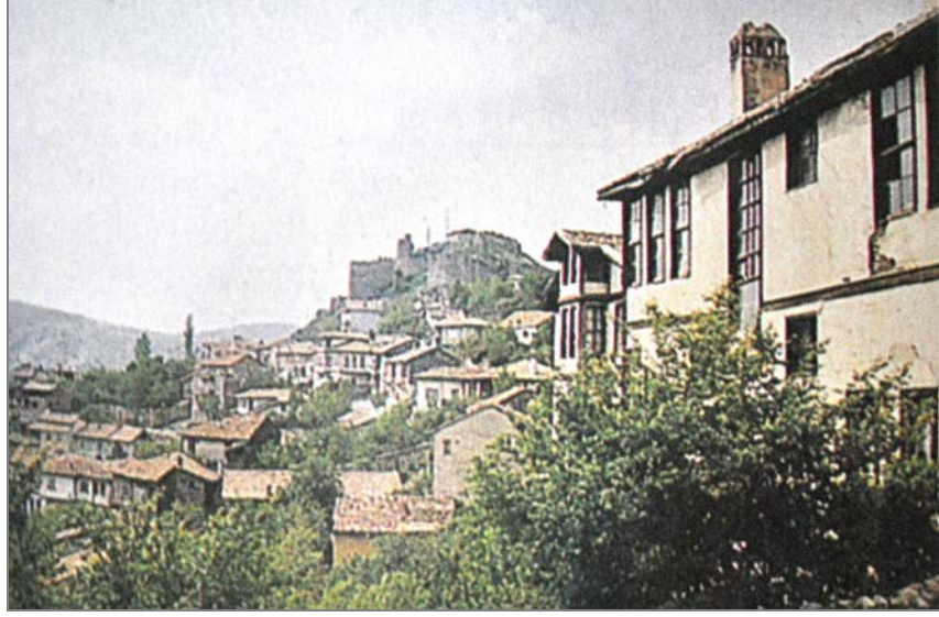
Şekil 2.11 Muğla, konut bahçelerindeki yeşil ögenin dokunun genel görünümüne etkisi (Bektaş [31])
