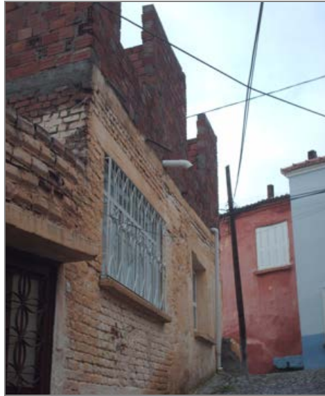
Şekil 5.19 Bergama, Gazipaşa Mahallesi, kat ilavesi
