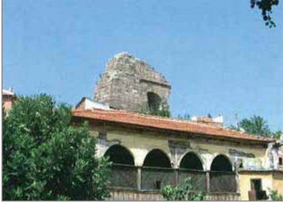
Şekil 4.38 Evin açık sofasının dıştan görünümü ve arkada Viran Kapı
