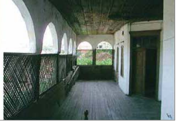
Şekil 4.39 Evin 1. katındaki açık sofaya bakış (Binan vd. [66])
