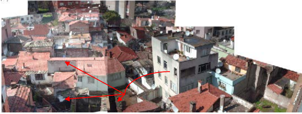
Şekil 5.3 297 no’lu yapı adasında imar planı kararlarına göre yapılmış yapının sokaktaki tek ve iki katlı yapılara göre durumu
