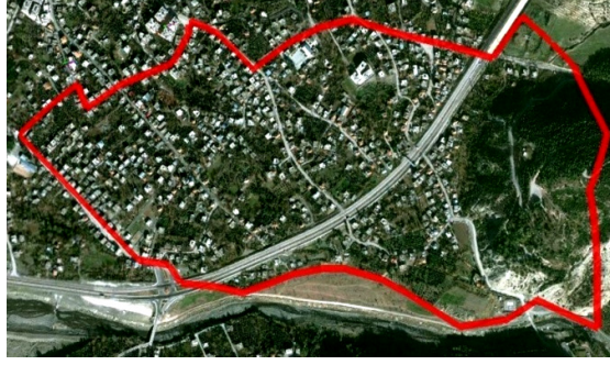
Şekil 4.6 Haraz mahallesi yerleşim dokusu
