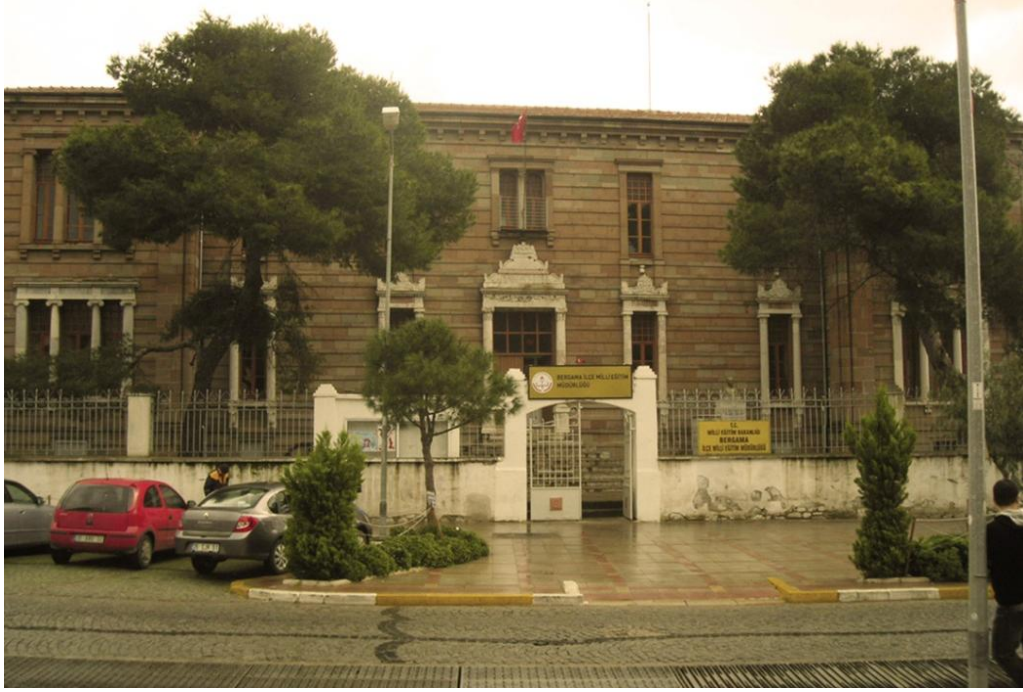
Şekil 5.31 Bergama İlçe Milli Eğitim Müdürlüğü'nün tescilli yapısı (Demir, 2009)
