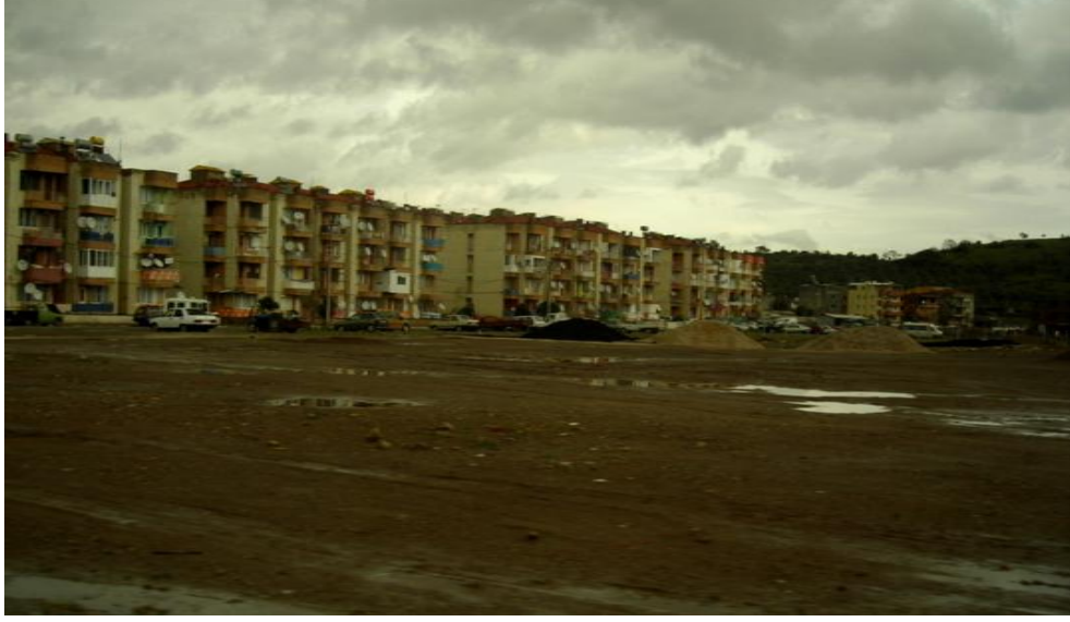
Şekil 5.20 Kontrolsüz/Yetersiz Altyapı ile Genişleyen Konut Alanları, Bergama (Demir,2009)
