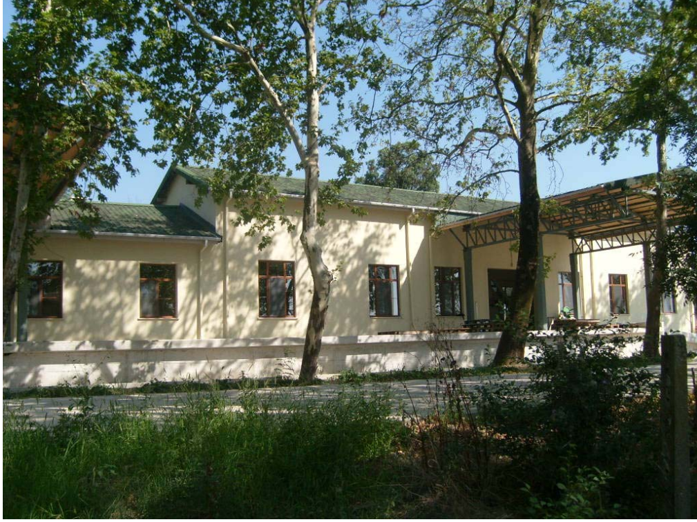
Şekil 5.21 Sinema ve lokanta yapısının değişen kullanım türü
