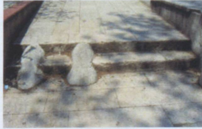
Şekil 3.5 Merdiven uygulamasından sonra (t)üretilen rampa Çengelköy, D. Toka, Mayıs 2009
