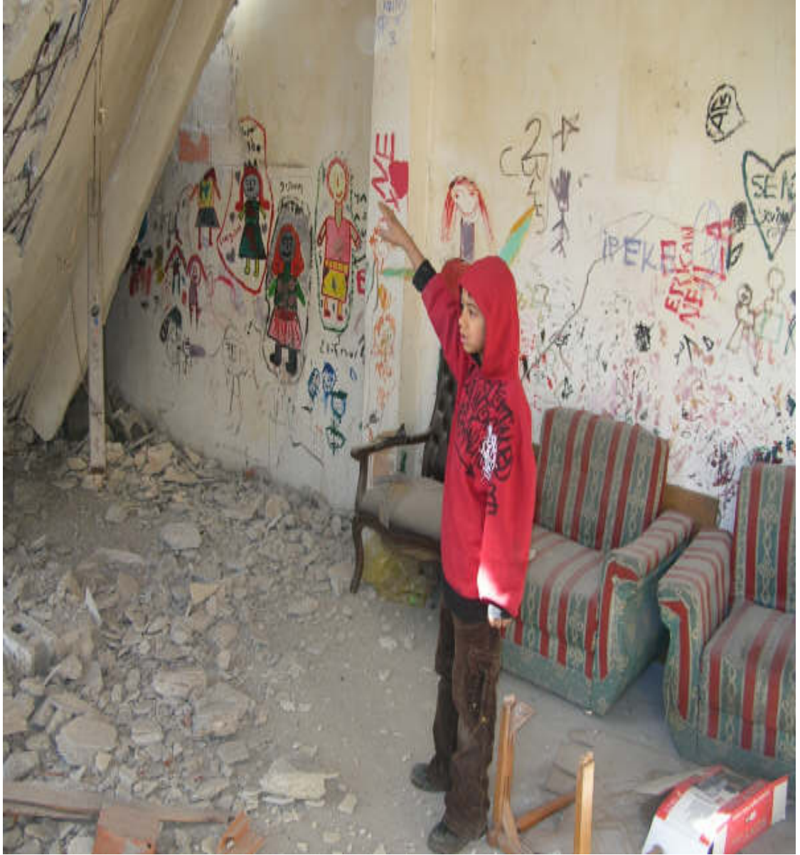
Şekil 5. Sulukule’de çocuk atölyesi olarak kullanılan yerin yıkılmış hali. (02.03.2009)
