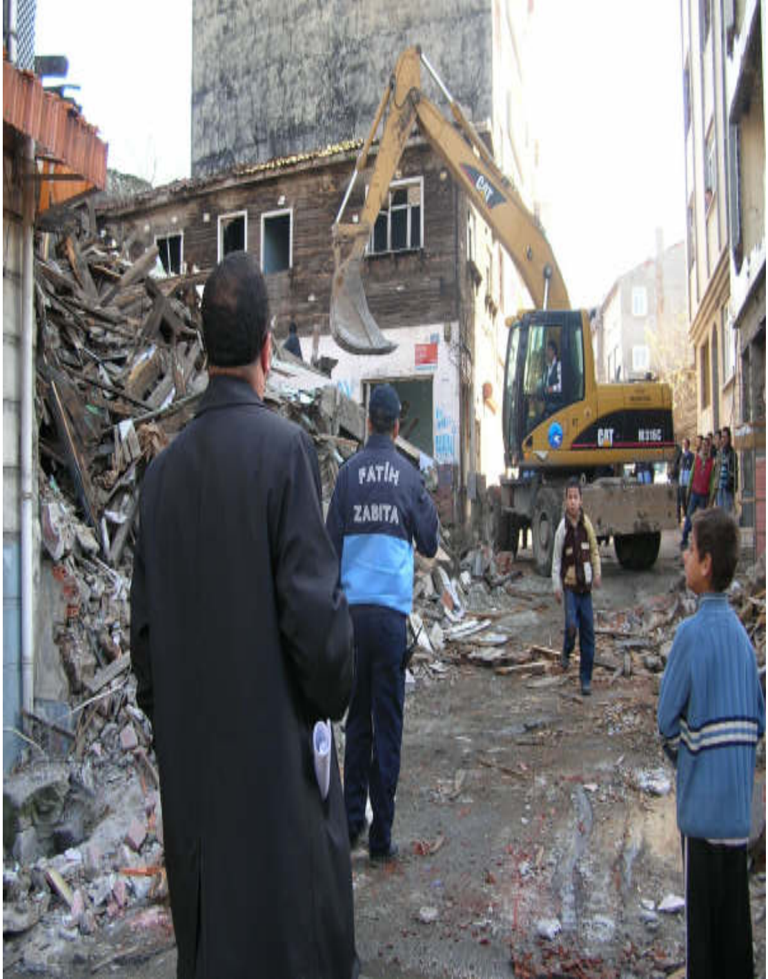
Şekil 3. Fatih Belediyesi ekiplerince bir yıkım anı. (17.02.2009)
