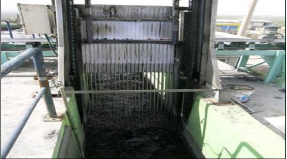
Şekil 3.1 Otomatik temizlemeli kaba ızgara [29]
