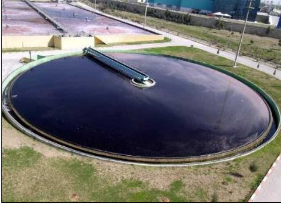
Şekil 3.5 Biyolojik çökertme havuzu örneği [29]
