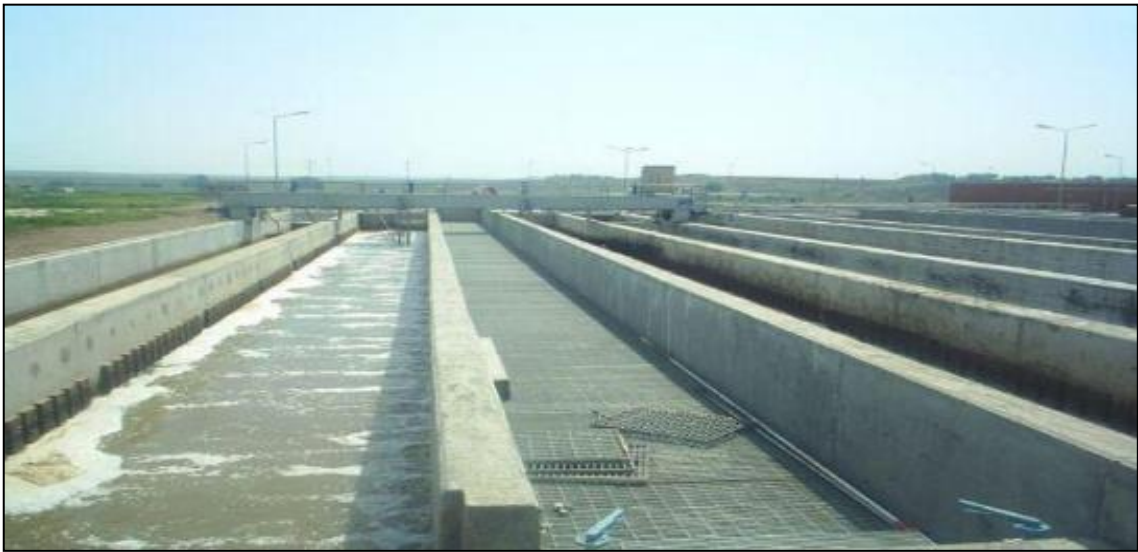
Şekil 3.3 Kum tutucu örneği [29]
