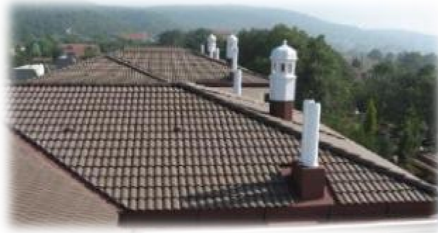
Şekil 3.1 İzolasyon tipi cam elyafı kullanılarak yapılan çatı kaplaması [3]
