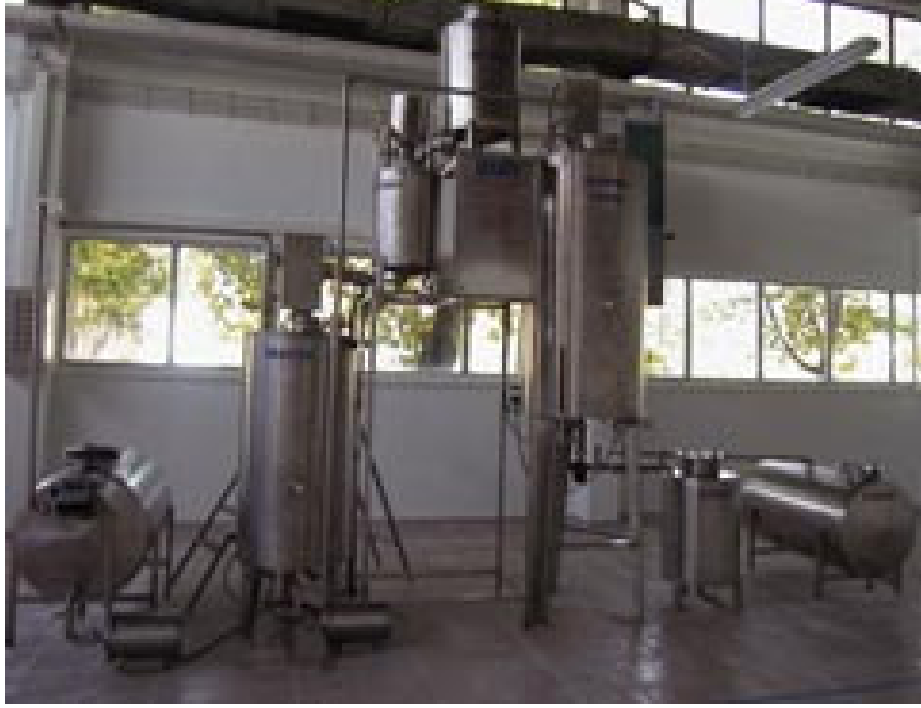
Şekil E3.2.1 Elektrik işleri etüt idaresi biodizel üretim pilot tesisi [5]
