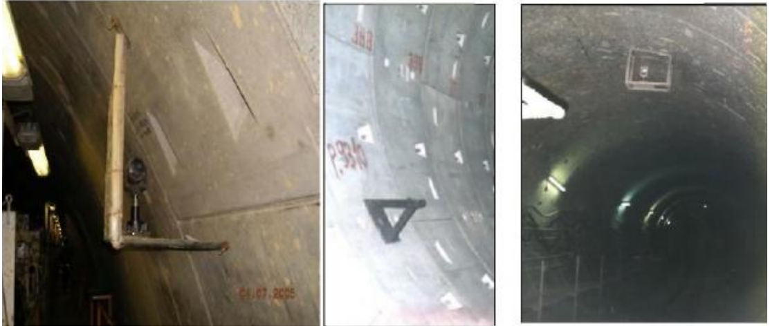
Şekil 3.31 Tünel duvarında değişik yapılarda poligon tesisleri[5]
