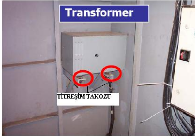
Şekil 4.2 Titreşim takozu görünümü örneği
