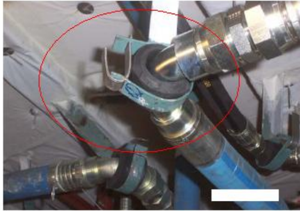
Şekil 4.5 Boru bağlantısı görünümü
