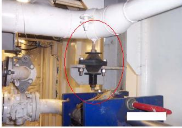
Şekil 4.4 Boru bağlantısı görünümü
