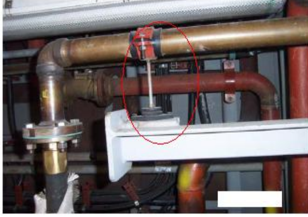
Şekil 4.3 Boru bağlantısı görünümü
