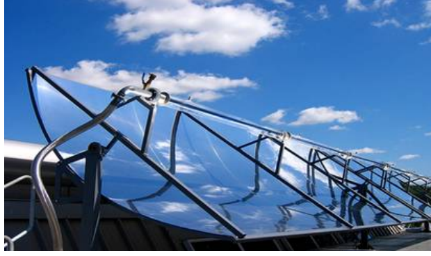
Şekil 4.2 Parabolik oluk tipi güneş kolektörü
