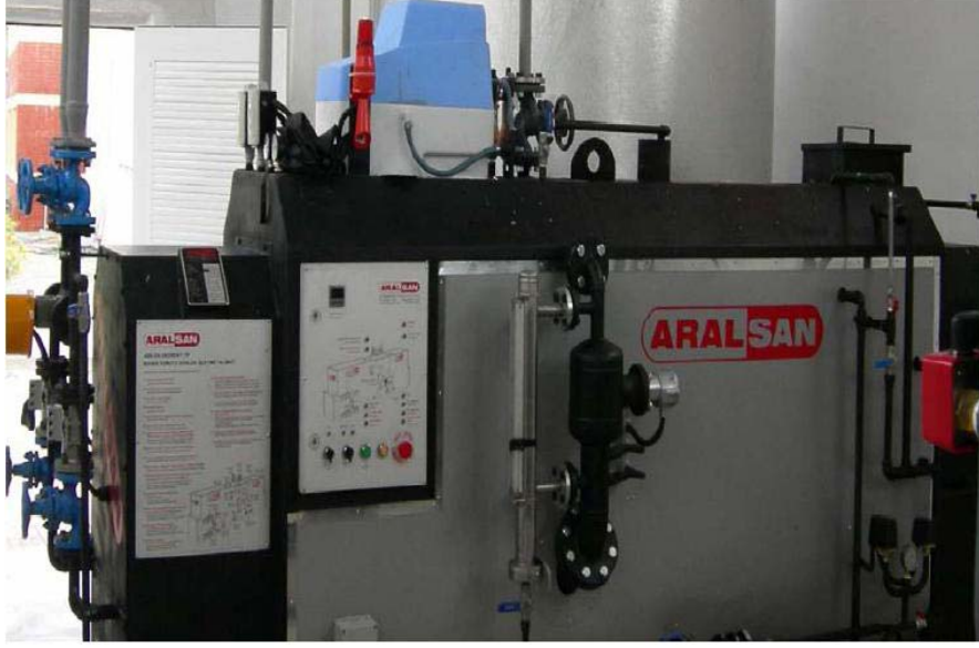
Şekil 6.1 Absorbsiyonlu soğutma sisteminde kullanılan buhar jeneratörü
