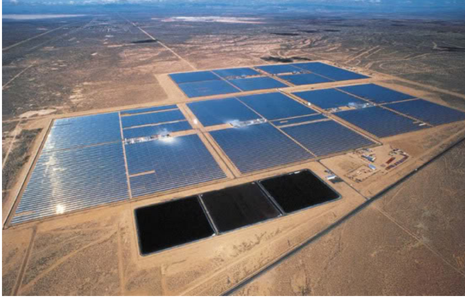
Şekil 4.1 Arizona’da bulunan 50 MW güce sahip güneş santralinin görünümü
