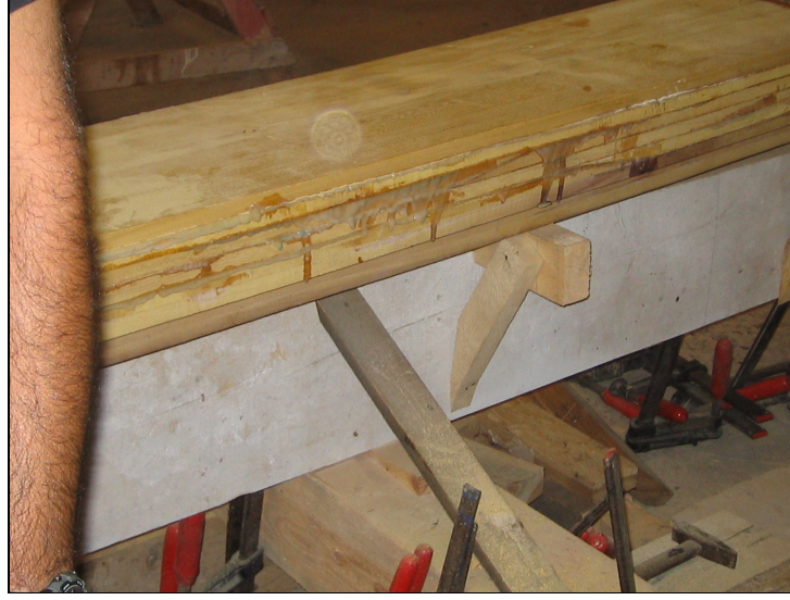
Şekil 4.2 Omurga laminasyonun yapıştırılması
