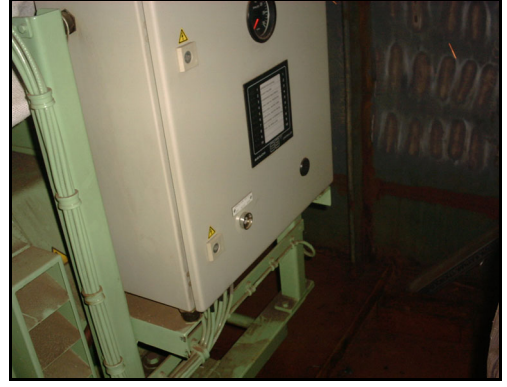
Şekil 4.25 Jeneratör kontrol panosu.
