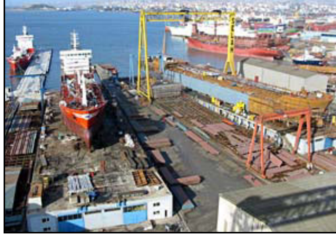
Şekil 6.48 Tersane alanındaki kaldırma ve taşıma altyapısı (açık saha kreynleri). [12]
