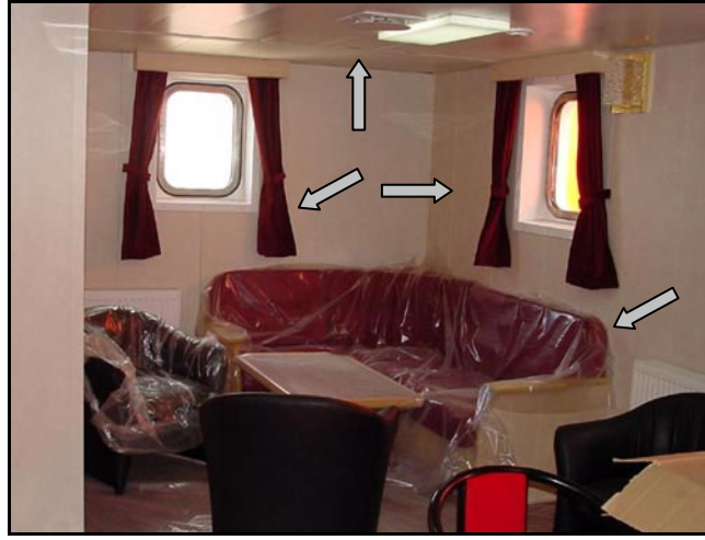
Şekil 6.67 Tavan ve duvar panelleri ile üst binadaki mobilyaların yerleştirilmesi. [15]
