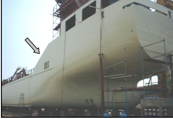
Şekil 6.50 Dış kaplamadaki ilk kat boyası.
