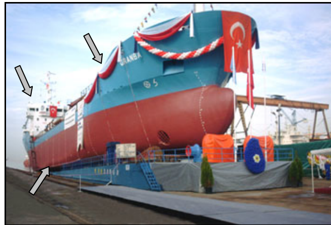
Şekil 6.54 Denize iniş öncesi üst bina ve harici kaplama boyasının bitirilmesi.
