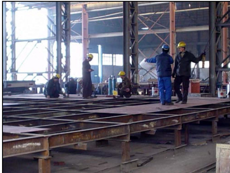
Şekil 6.31 Birleştirilecek olan panel saclarının üretim tezgahına serilmesi. [15]
