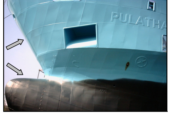
Şekil 6.51 Kat boyalarının uygulanması.
