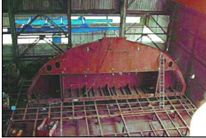
Şekil 6.37 Kapalı atölyede klas kuruluşu kontrolleri için bekletilen kıç pik bloğu. [15]
