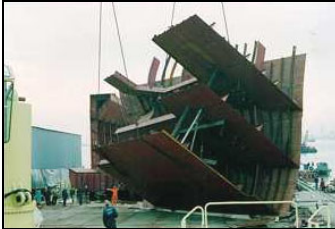
Şekil 6.38 Bloğun kaldırılması ve çevirilmesi operasyonu. [12]
