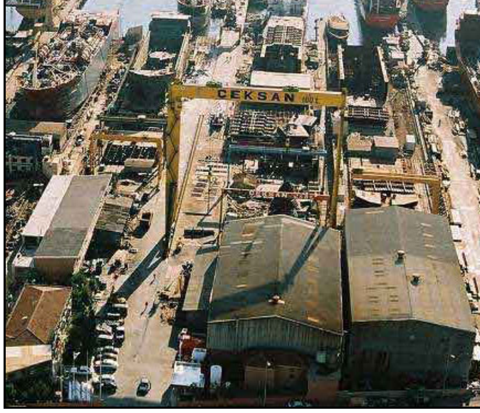
Şekil 6.3 Açık saha jigleri ve gantry servis kreyinleri. [16]
