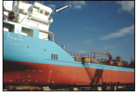
Şekil 6.53 Üst binanın boyanması.
