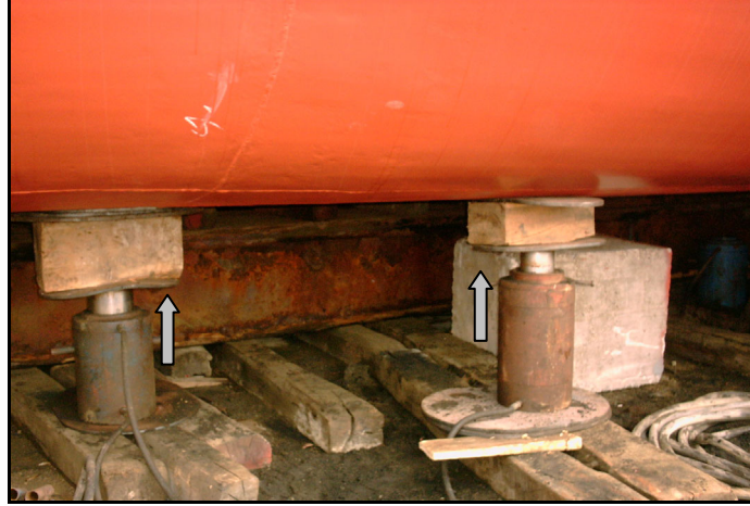
Şekil 7.13 Krikolar ile kaldırma işlemi.
