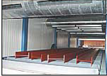
Şekil 6.23 Shop-primer boyama işlemi. (Şen, 2004)
