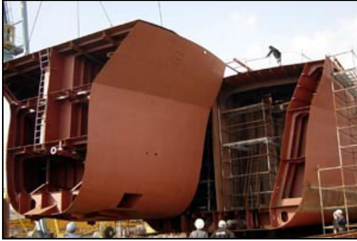
Şekil 6.45 Kaldırılan bloğun taşıyıcı yapılara ve önceki bloğa yaklaştırılması. [15]
