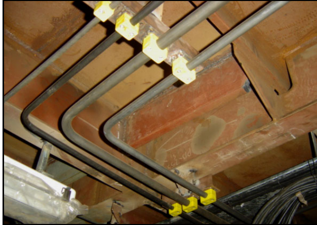
Şekil 4.16 Kumanya kreyini ve bot mataforası hidrolik bağlantıları.
