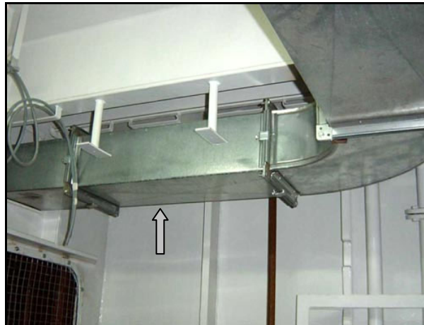
Şekil 6.68 Yaşam mahali ve makina dairesi havalandırma kanalları. [15]
