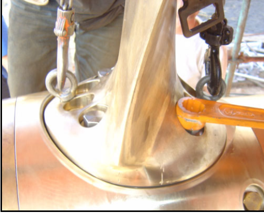
Şekil 4.21 Pervane kanatlarının bağlanması.
