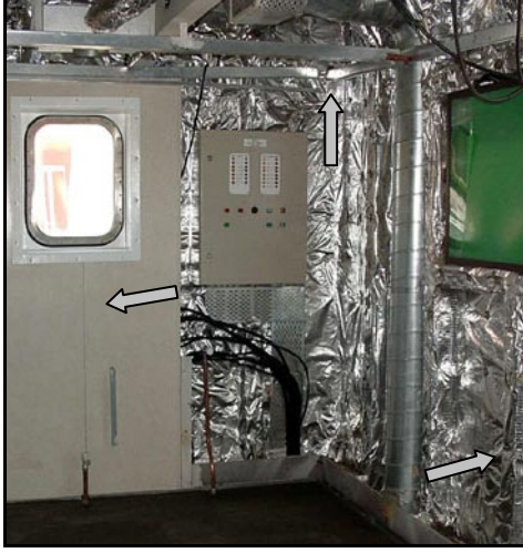
Şekil 6.65 İç mekanların izole edilmesi. [15]
