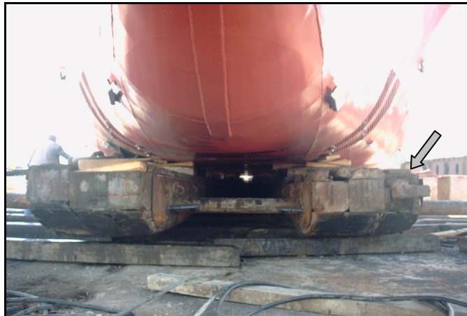
Şekil 7.14 Kayıcı kızıağın yerleştirilmesi.
