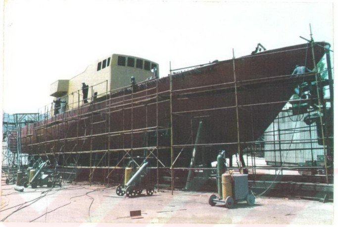
Şekil 7.12. Kızak üzerinde blok ve üst bina montajı tamamlanmış tekne
