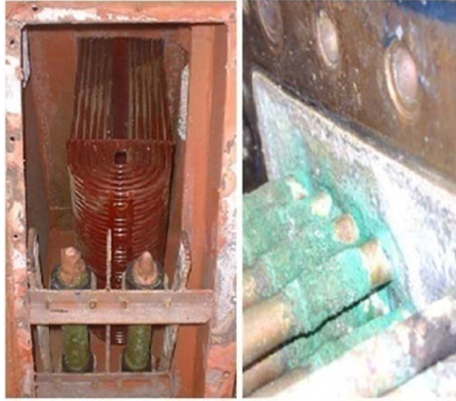
Şekil 4.10 Reçine kaplanmış (solda) ve kaplanmamış (sağda) SS cihazlar [9]
