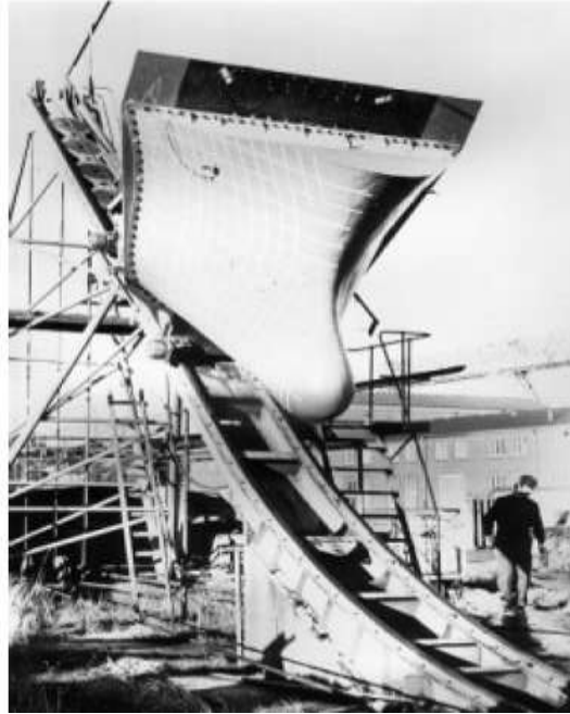
Şekil 1.2 Woisin test düzeneği [3]
