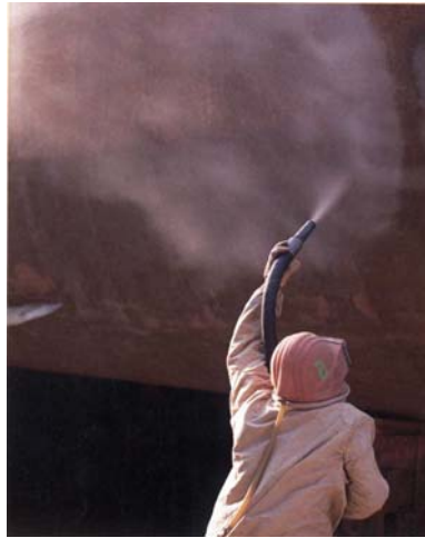
Şekil 8. 2 Boya Öncesi Yüzey Hazırlık İşlemi (Çelebi, U.B., VARDAR, N., Gemi Onarım Sektörünün Çevre Kirliliğine Etkisi, 2006)
