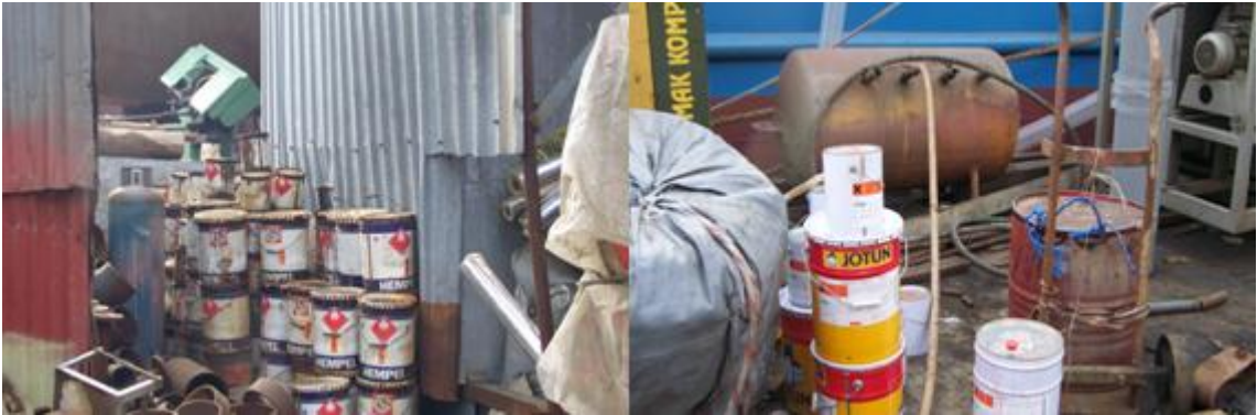
Şekil 8.28 Söküm Sonucu Açığa Çıkan Boya ve Kimyevi Atıkları ve Ambalajları
