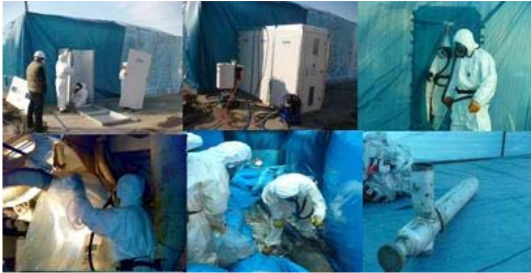
Şekil 8. 20 Aliğa Gemi Söküm Bölgesinde Gerçekleşen Asbest Söküm İşlemlerinden Görüntüler (GEMİSANDER)
