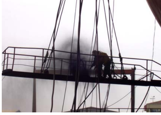
Şekil 8.7 Yüzey Boyası Uygulama İşlemi Esnasında Açığa Çıkan Gaz Emisyonları (Çelebi, U.B., VARDAR, N., Gemi Onarım Sektörünün Çevre Kirliliğine Etkisi, 2006)
