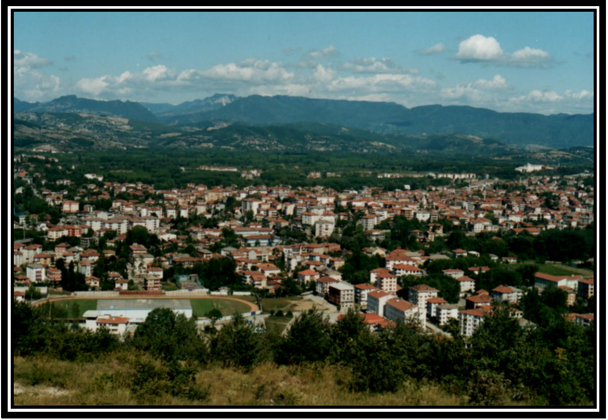
Şekil 4.9 Bartın merkezindeki yerleşik alan
