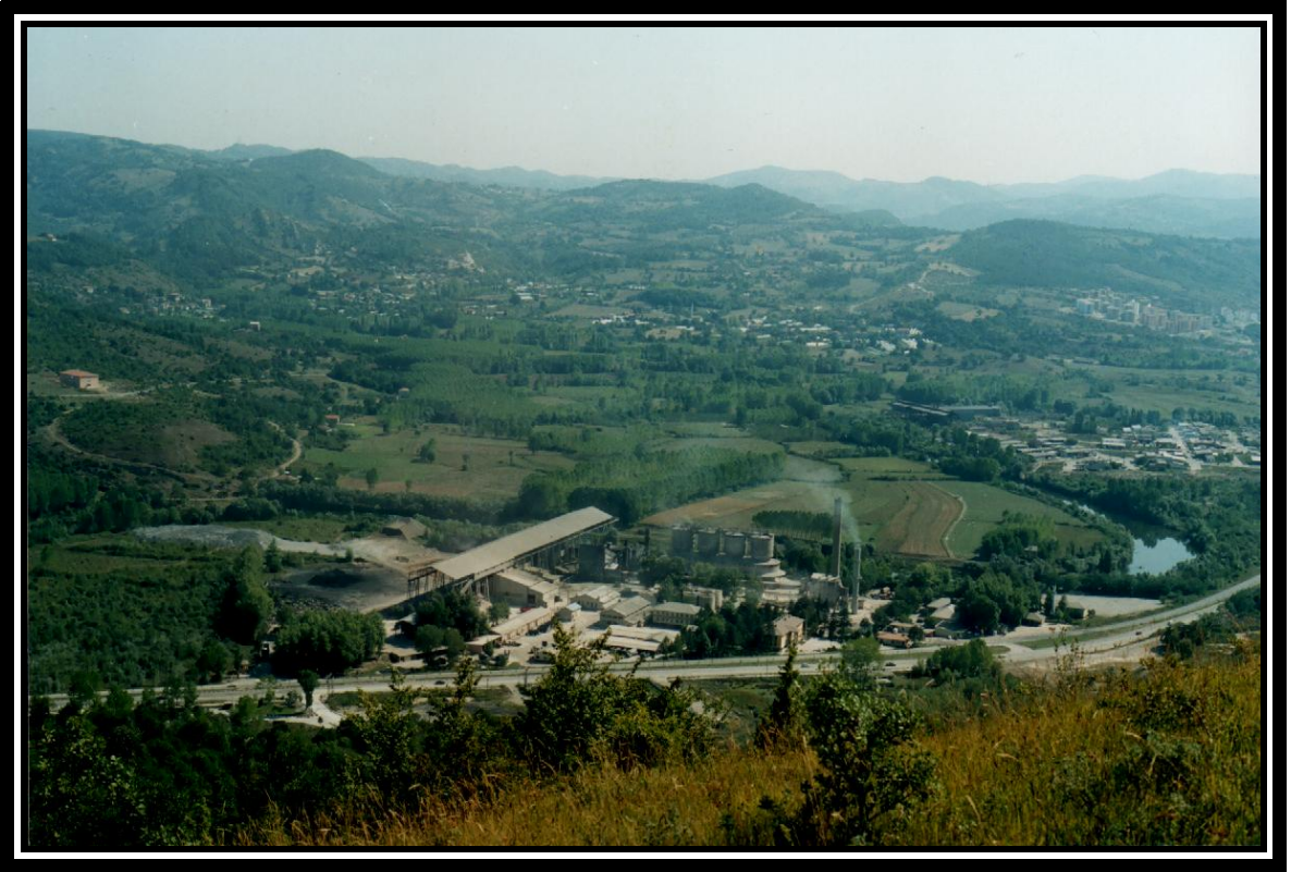
Şekil 4.7 Bartın Çayı kenarına kurulmuş olan çimento fabrikası.
