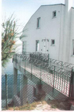
Şekil 5.3. Kıyıda olması gereken uygulamaya aykırı yapılara örnek (Burgazada )
