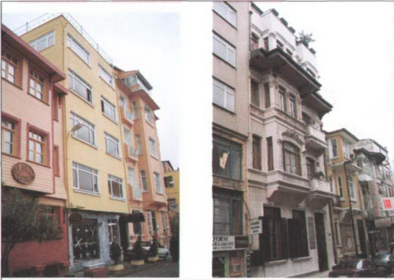
Şekil 4.39. Yapı yapma yasağı kararına aykırı örnekler
