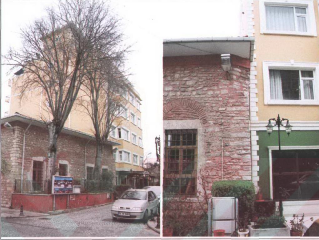
Şekil 4.38. Yapı yaklaşma mesafesinin aşıldığı uygulamalar
