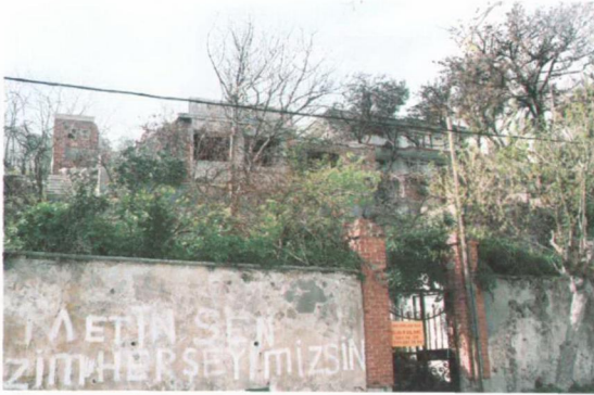
Şekil 4. 10. Yıkık olarak nitelenen binalara örnek
